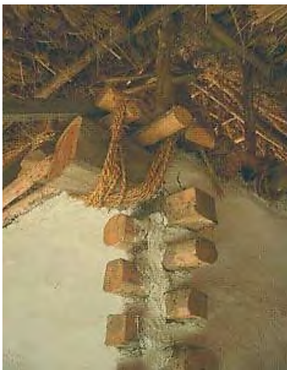
تصویر شماره ۱۶: دو سر گردبینه/گرددارها در گوشه‌ها به صورت فاق و زین. مأخذ: احمدی، ۱۳۹۳.
