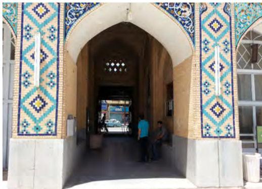
تصویر شماره ۸: راهروی ورودی و سنگ آب مسجد ملک (امام خمینی).
