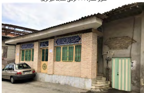
تصویر شماره ۲۰: مسجد امام حسن بدون فضای خدماتی.
