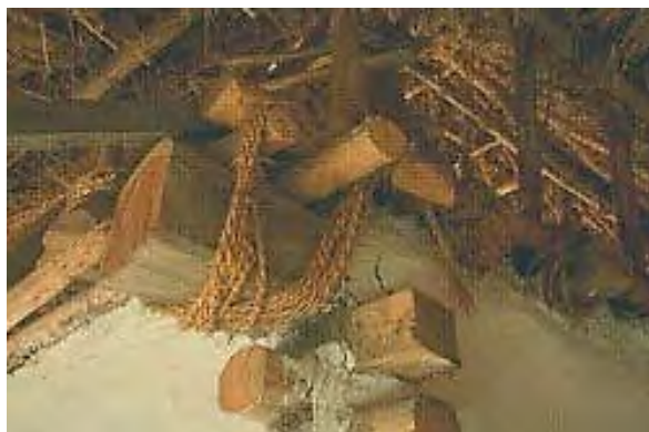
تصویر شماره ۶۴: اتصال کام و زیانه خربا.
