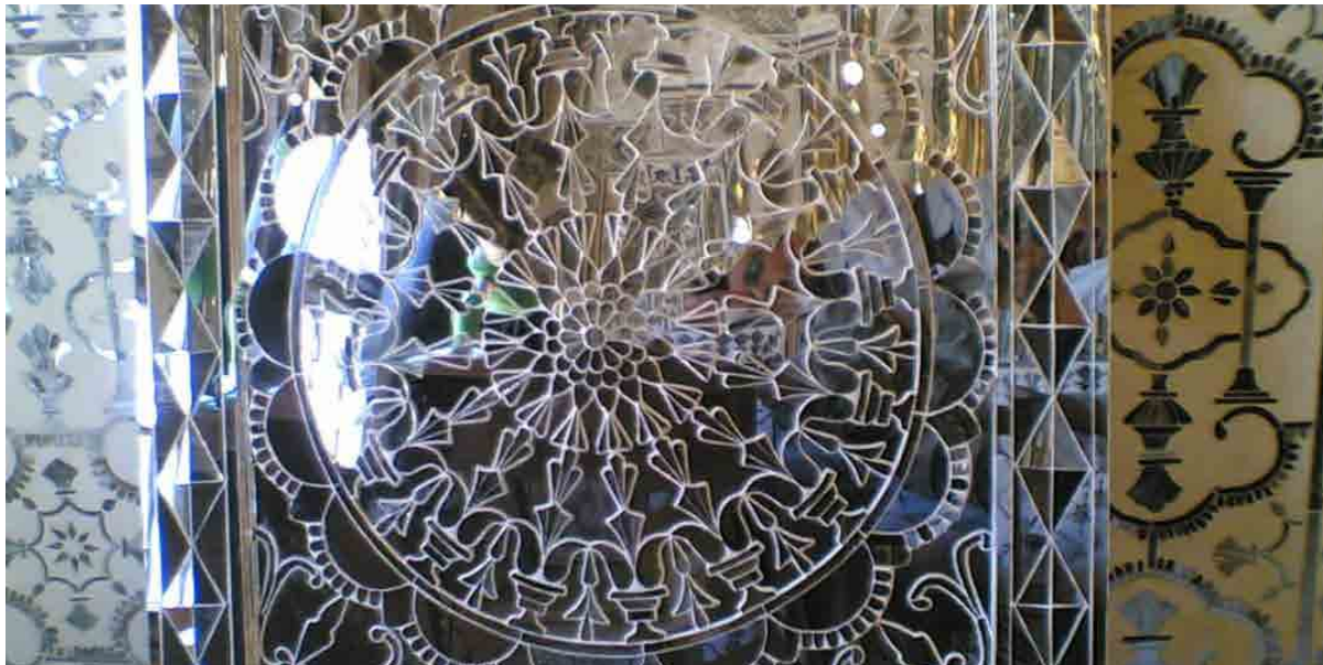
تصویر شماره ۸: نمونه کار بازوبندی با روش آینه روی آینه و گچ کشی دور آینه روی آینه. مأخذ: علی حسام پور، ۱۳۹۸.
