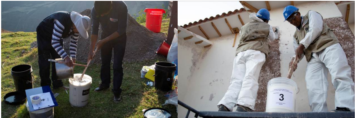
Figura 4 – Maestros de obra de la DDC–C preparando los materiales y aplicando la primera capa de una de las muestras de acabado a base cal y arena en noviembre 2020. Fotografía Luís Villacorta Santamato © 2020, J. Paul Getty Trust
