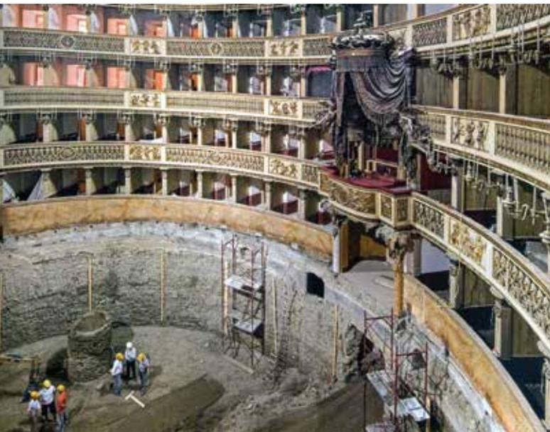
Abb. 5 Teatro di San Carlo, Neapel, über fünf Meter tiefer Aushub unterhalb der Parterrezone: Platz für das neue Foyer
