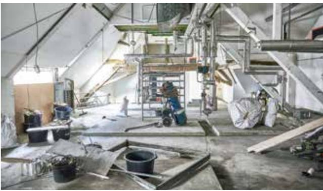
*Abb. 4 Sanierung der Lüftungszentrale im historischen Dachbereich des Zuschauerraums. Zu sehen sind hier auch die ältesten erhaltenen Holzbestandteile der historischen Dachkonstruktion.*
