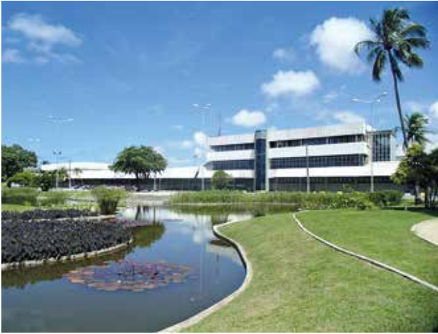
Fig. 11: Praça Salgado Filho, Recife, after restoration (photo A. R. Sa Carneiro)
