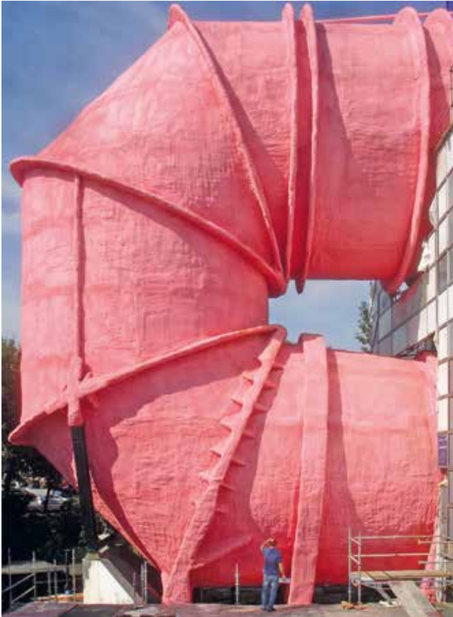
Fig. 7: Polyurethane foam after restoration, 2017 (© adb Ewerien und Obermann)
