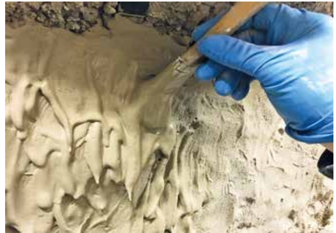
Abb. 20: Antrag von Romanzement in Fließform
