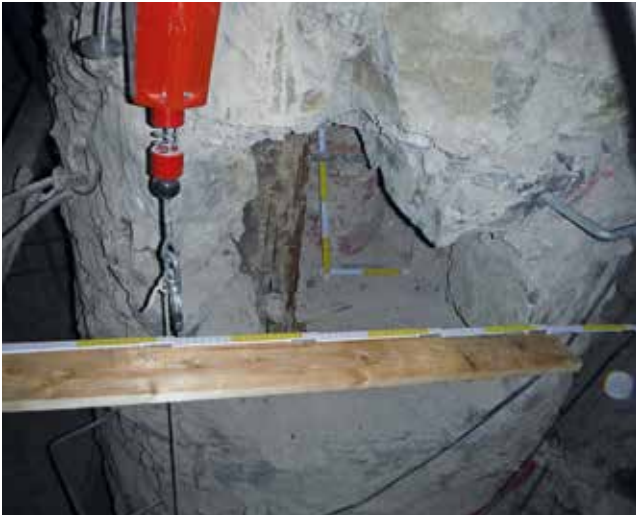
Abb. 6: Große Mittelsäule, mit Befundöffnung zur Freilegung des Gusseisenkerns
