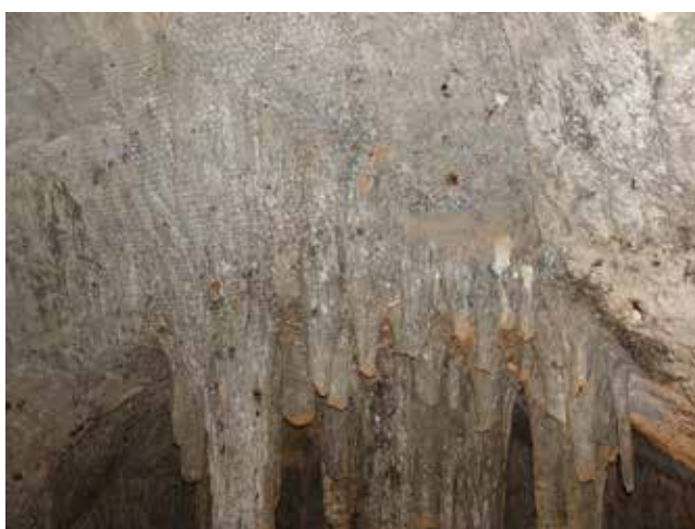
Abb. 9: Sandwichelement, Sicherung leicht geschädigter Putzbereiche durch ein eng anliegendes und kaum sichtbares Sechseckgeflecht aus Edelstahl. Das Sicherungselement wurde im Baulabor geprüft und als sicher eingestuft. Es wird zur zusätzlichen Sicherung der Führungslinie eingesetzt. Dass dieses System auch an den kompliziert geformten Teilen, z. B. Stalaktiten, gut funktioniert, zeigt dieses Foto.
