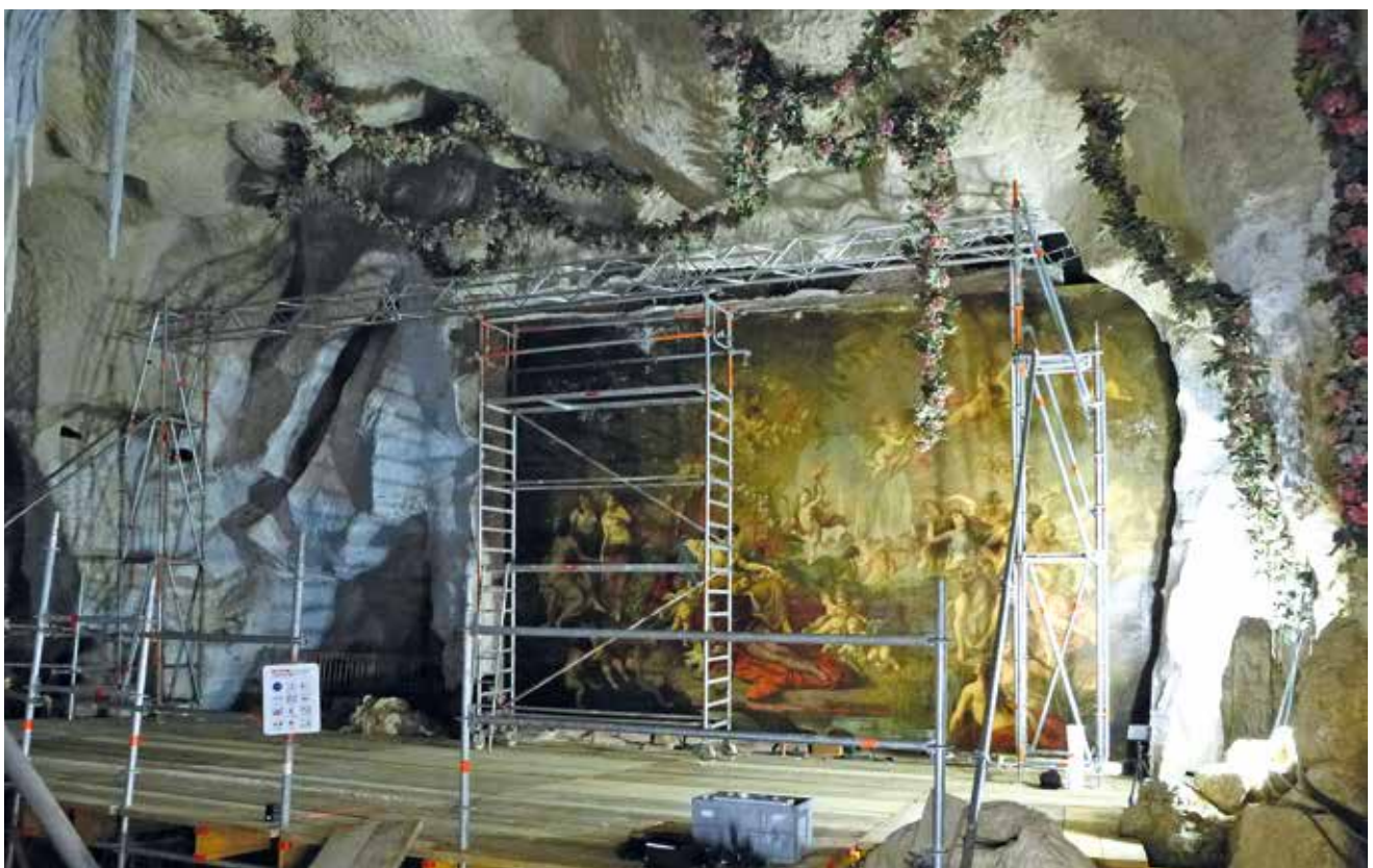
Abb. 6: Gerüsttürme und Arbeitsplattform
