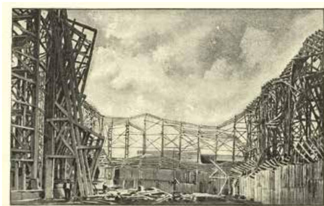
Abb. 15a und b: Henneberg & Fils: Unterkonstruktion der Kunstfelsenfassade für das Panorama des Alpes Suisses, Village Suisse, Weltausstellung 1900, Paris (aus: Anonym, L'Exposition de Paris , Paris 1900, Bd. 1, S. 294 und 295)
