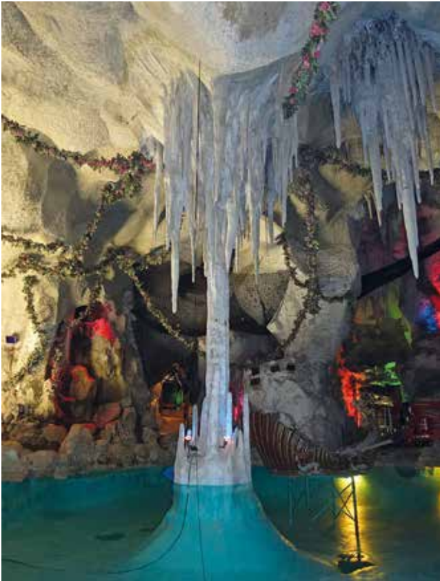
Abb. 5a: Seesäule mit umgebender Tropfsteingruppe – Umkleidung der Gusseisensäule b: Bauteilöffnung an der Seesäule mit freigelegtem Gusseisenkern
