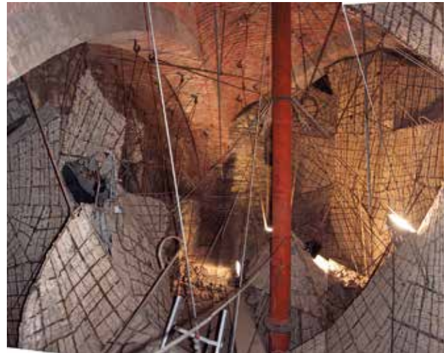
Abb. 7: Schalenzwischenraum am Zugang zum Ausgangstunnel mit zahlreichen Varianten von Hängern zwischen Gewölben und Schale
