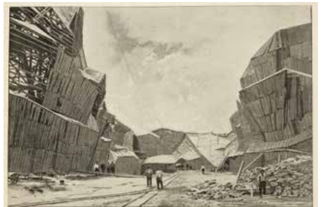
Abb. 15a und b: Henneberg & Fils: Unterkonstruktion der Kunstfelsenfassade für das Panorama des Alpes Suisses, Village Suisse, Weltausstellung 1900, Paris (aus: Anonym, L'Exposition de Paris , Paris 1900, Bd. 1, S. 294 und 295)
