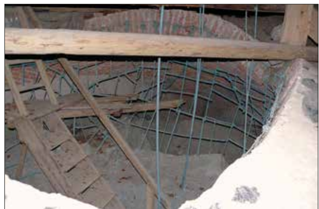
Abb. 6: Ursprüngliche Beleuchtungsöffnung im Gewölbe
