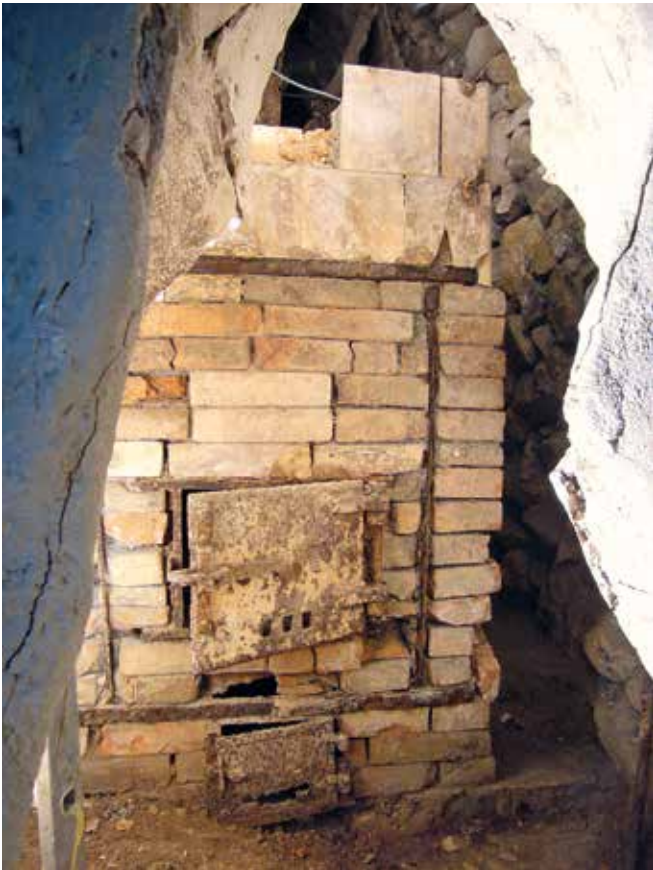
Abb. 3a und b: Kachelofen I während des Abbaus a) Vorderseite des Feuerkastens mit Feuerungstür (oben) und Tür zum Aschekasten (unten) b) Rückseite des Kachelofens mit freigelegten Heizzügen und mittigem Warmluftschacht
