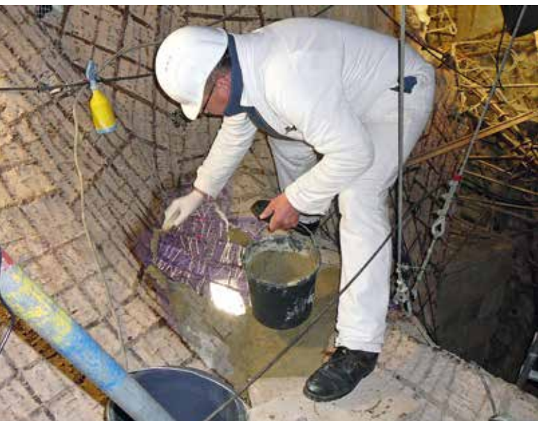
Abb. 4: Anlegen eines Reparaturmusters
