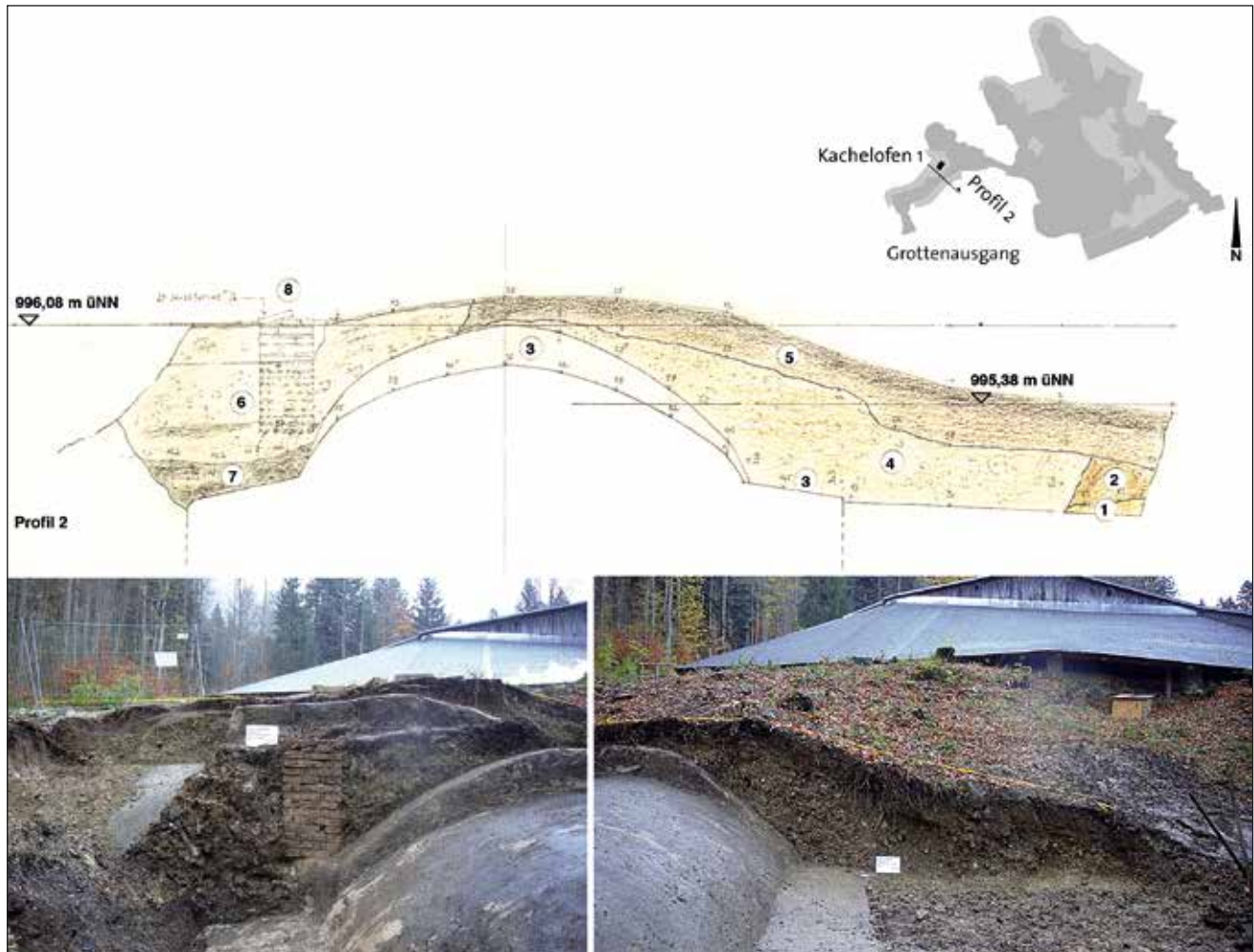
Abb. 6: Oberseiten der Gewölbe über dem Grottenausgang mit der in mehreren Erdschichten aufgetragenen Überdeckung
