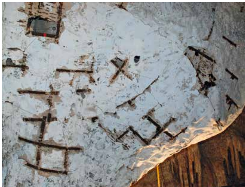
Abb. 5: Korrosion
