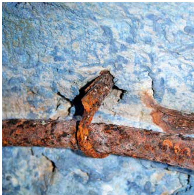
Abb. 7: Verankerung der Wasserleitung zum Sprühkopf auf blau gefasster Raumschale
