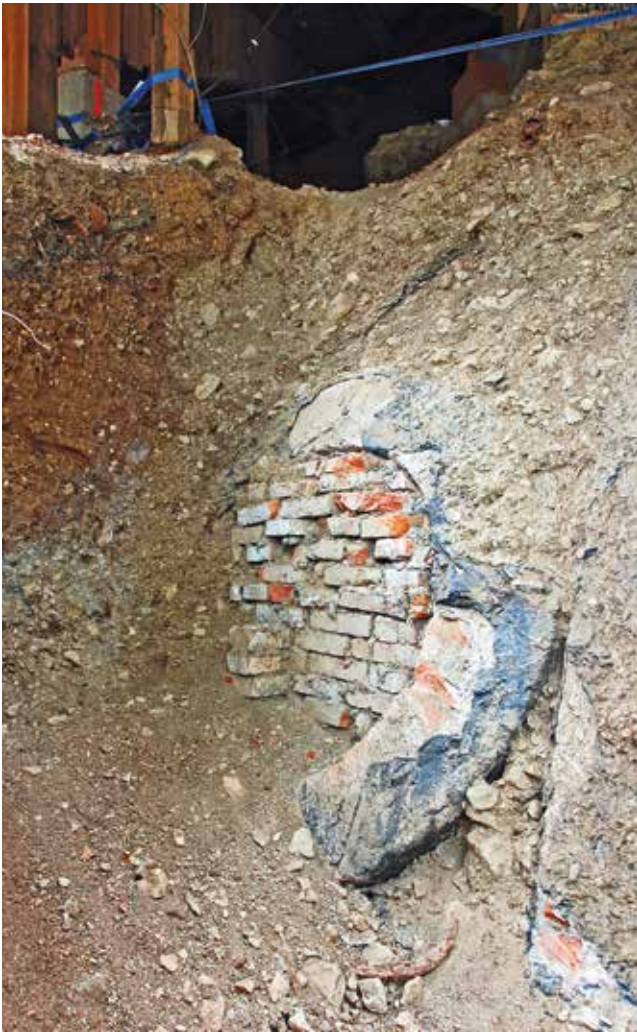
Abb. 16: Zugeseztes Rundfenster im südwestlichen Gewölbeabschnitt, Situation während der Freilegung der Gewölbeoberseiten
