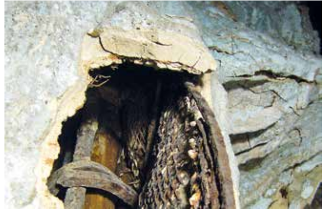
Abb. 7: Die partiell bis zu 7 cm dicke Drahtputzschale
