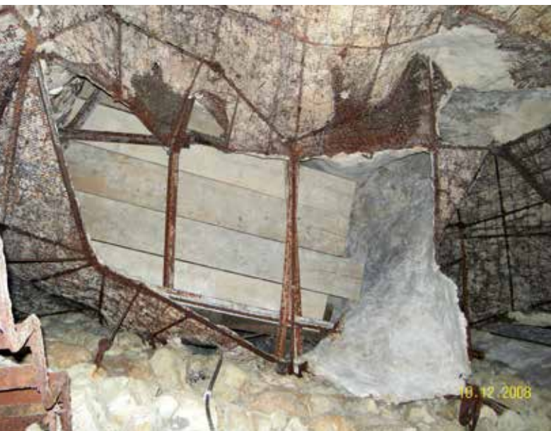
Abb. 18: Blick von unten auf die Beleuchterkanzel über Ofennische 5 in der Hauptgrotte. Links unten das Fragment der eisernen Stiege
