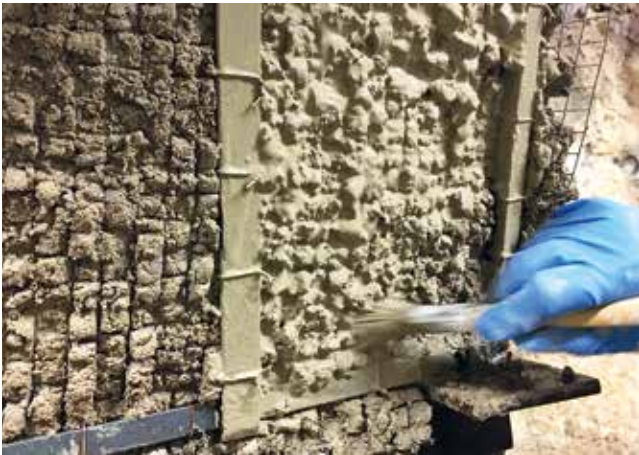
Abb. 19: Auftrag der Romanzementschlämme auf den erhärteten Rückseitenmörtel
