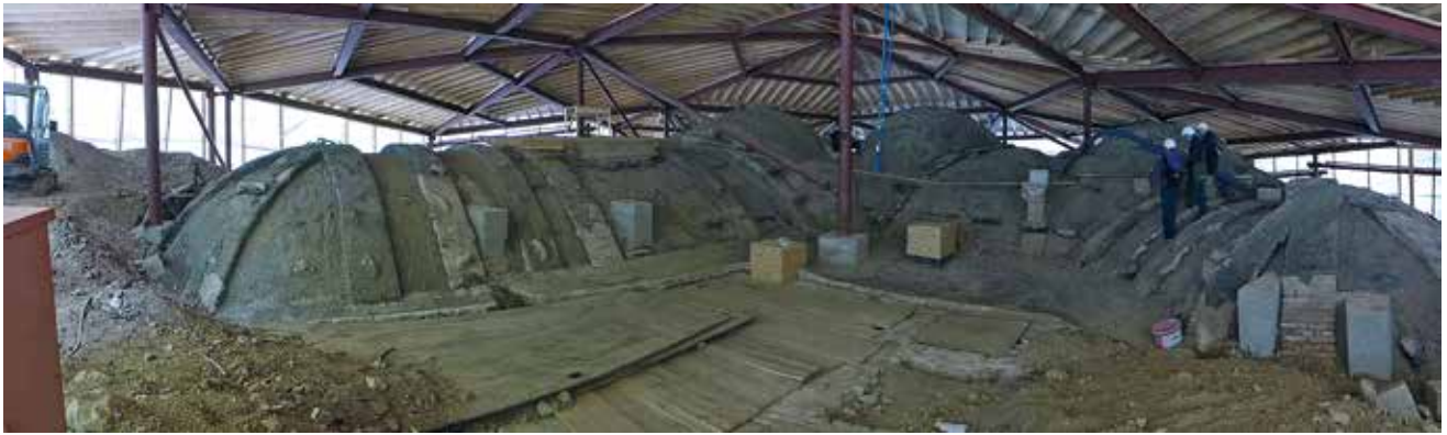
Abb. 1: Ansicht freigelegter Gewölbereiche von außen unter dem modernen Schutzdach
