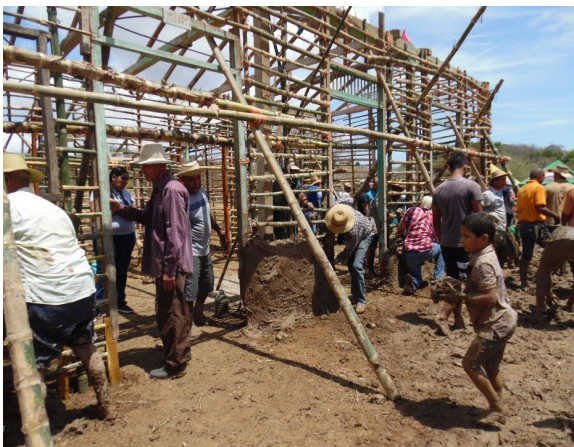
Figura 6. Junta de embarre de la casa de quincha de Orlando Barcasnegras en El Sesteadero, Los Santos -región de Azuero- © Silvia Arroyo
