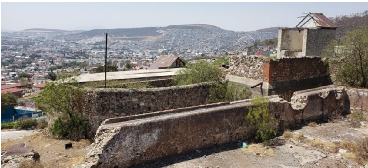
Figura 6. Mina la Corteza, tuvo una máquina de vapor Cornish para desaguar los túneles mineros durante el S. XIX © M. E. Sanchez Roldan, 2021
