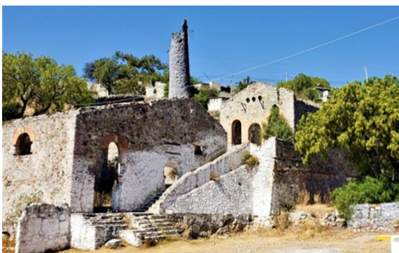
Figura 5. Mina Camelia, Barrio Fundacional de Camelia construida en 1901 © M. E. Sanchez Roldan, 2021
