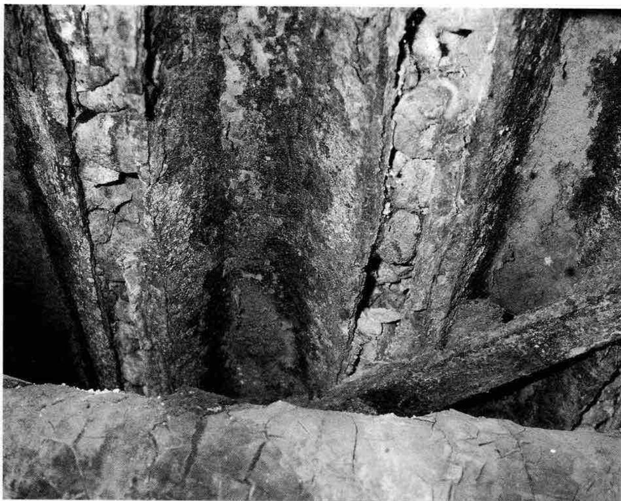
Lo stato attuale delle traversine *Wauterin* del ponte ad archi di ferro presso la Specola.
