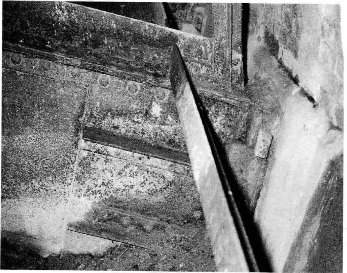
L'imposta dei sei archi in ferro costituenti la struttura principale del ponte alla Specola. L'appoggio fra la piastra del piede dell'arco e quella fissata al muro di testata del ponte era regolabile con una serie di biette cuneiformi. Le biette sono di acciaio e le piastre d'appoggio sono in ghisa.
