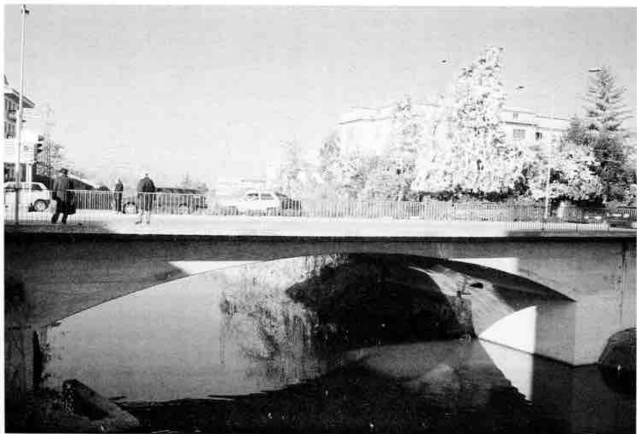
Le spalle del ponte in ghisa di S. Croce sono ancora esistenti. Il ponte della fonderta padovana fu in opera fino al 1910 data nella quale fu sostituito da uno in calcestruzzo per il passaggio della linea tramviaria.
