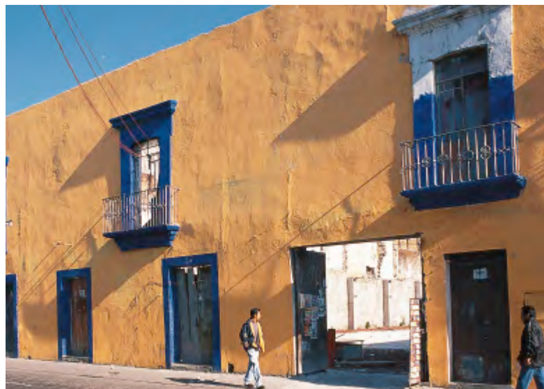
II. 11: Detrás de esta fachada con vanos sin vida y expresión se ha demolido un bello patio. El terreno en la actualidad se utiliza como estacionamiento.
