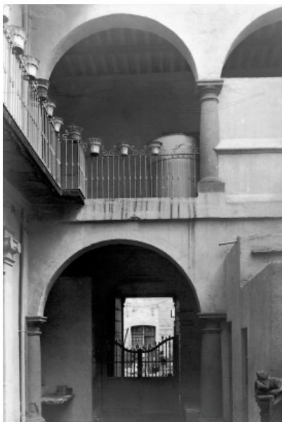
Arcadas del primer patio.
