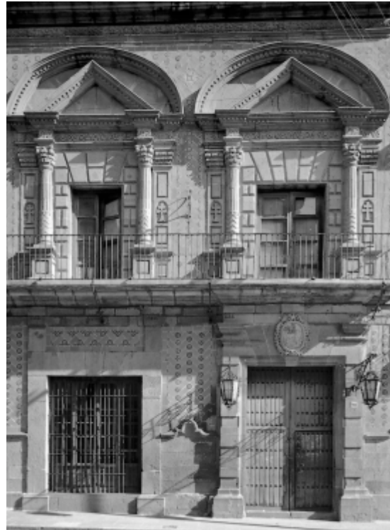
Fachada (parte occidental).
