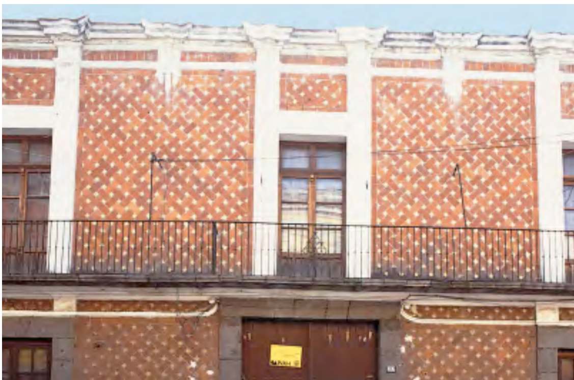
Detalle de la fachada principal.
