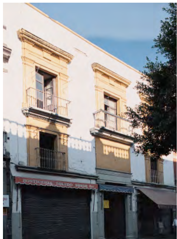
Fachada del edificio.
