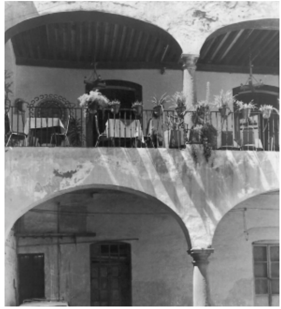
° Calle 4 Norte 403 (n° cat. 230) La arcada con arcos de tres puntos es sumamente austera.
