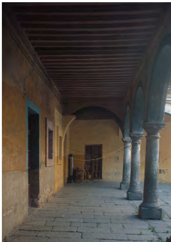
El pasillo cubierto.
