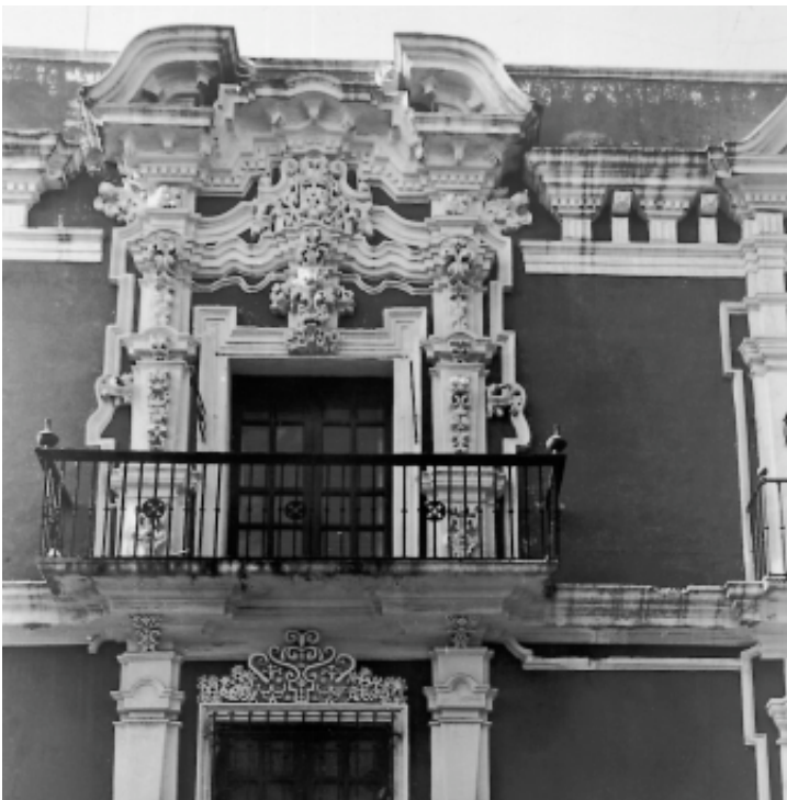
° Av. 2 Oriente 15 (n° cat. 143) El marco de la puerta en la planta alta decorado con cornisas da la impresión de movimiento.
