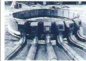
Nervaduras de la bóveda central y base del grupo escultórico, en proceso de fabricación.
