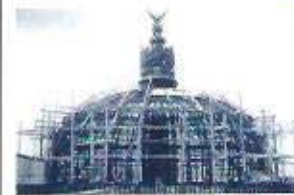
Se observa la estructura con sistema roebing colocado aproximadamente a tres cuartos partes de la superficie total
