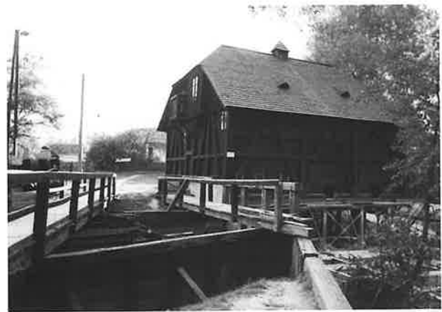
Túrístvánd, water-mill (Photo by Géza Kulcsár)
