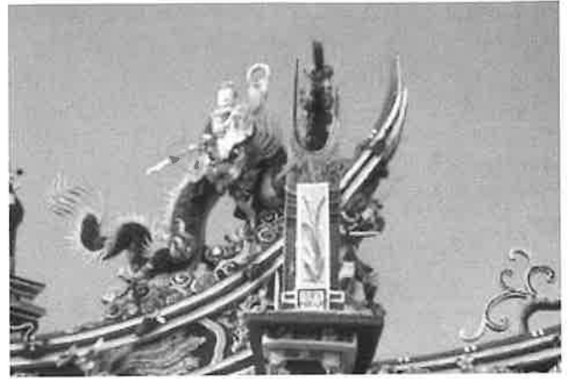
A temple's ridge in Taiwan after restoration Faite d'un temple à Taiwan après la restauration
