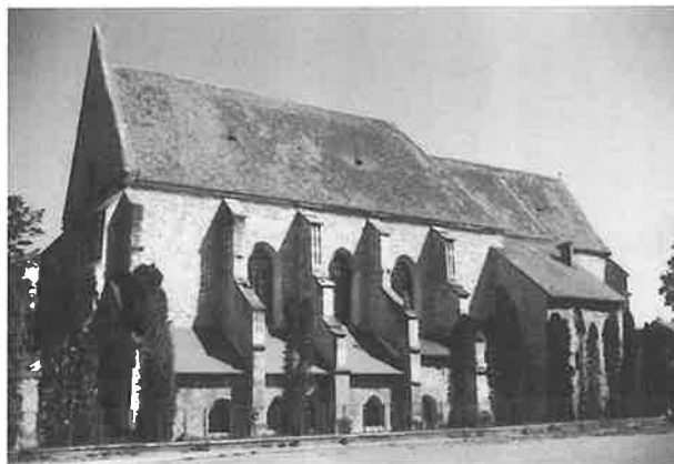
The church in Farkas Street, Cluj (Romania) Église de la Rue Farkas, Cluj (Roumanie)
