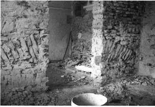
Bridged Arch cut off in the house of the butchers Arc de décharge percé, de la maison des bouchers
