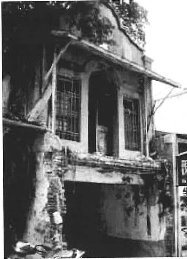
Fig. 2. Demolition of the façade in Yen Ping Street Fig. 2. Démolition de la façade dans la rue Yen Ping
