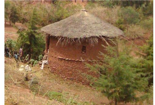
Exemple de Tuluk, maison ronde à deux étages, construite en pierres et mortier de terre. Sur cet exemple, l'enduit extérieur en terre a presque entièrement disparu.
