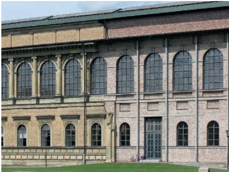
Abb. 12 Fassadendetail der Alten Pinakothek in München, mit der Schließung der Bombenlücke durch den Architekten Hans Döllgast aus den 1950er-Jahren (© Wikipedia Commons (2012))
