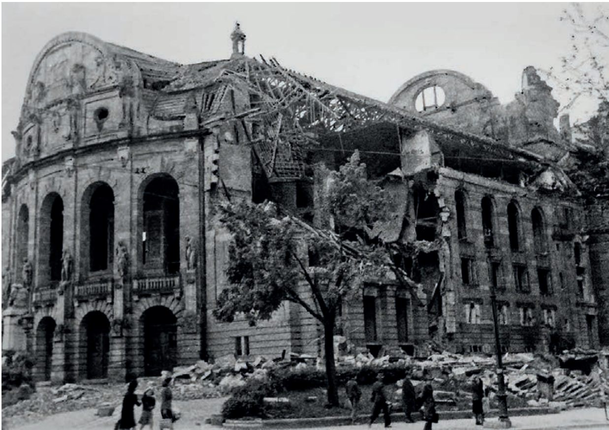
Abb. 7 Das Stadttheater in Freiburg i.Br., erbaut 1905-10, nach dem Luftangriff von 1944. Der als hässlich empfundene Diademgiebel wurde für instabil erklärt und beim Wiederaufbau abgetragen (© Wikipedia Commons, Stadtarchiv Freiburg i.Br.)
