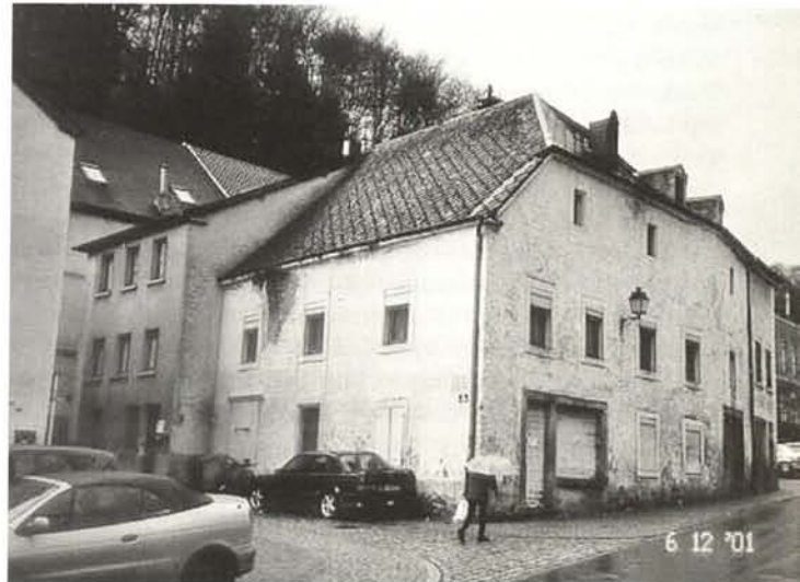
Maison démolie Demolished house
