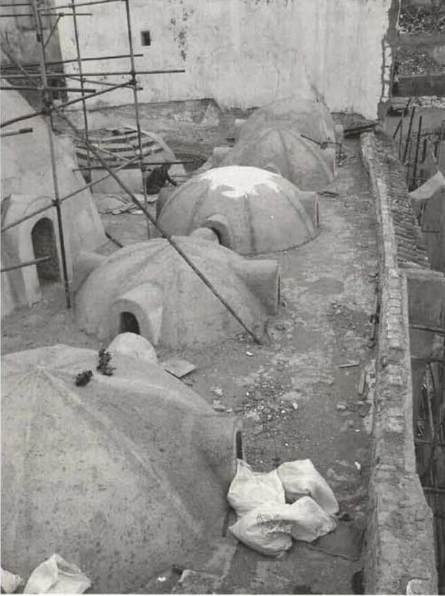
Mosquée Ali Betchin. Le recours systématique à l'enduits à base de ciment fournit souvent le prétexte pour contourner les vrais travaux de restauration
