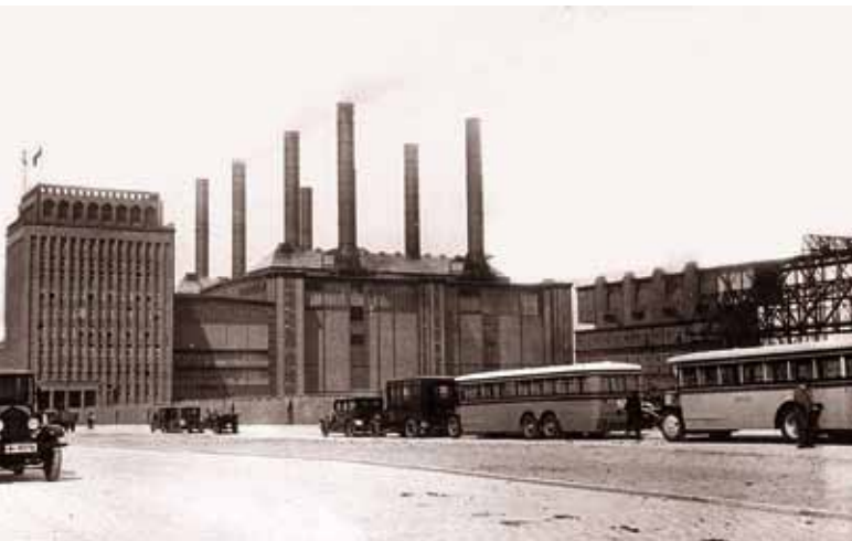
Abb. 6: Kraftwerk Klingenberg, 1925–26 von Walter Klingenberg und Werner Issel, um 1930
