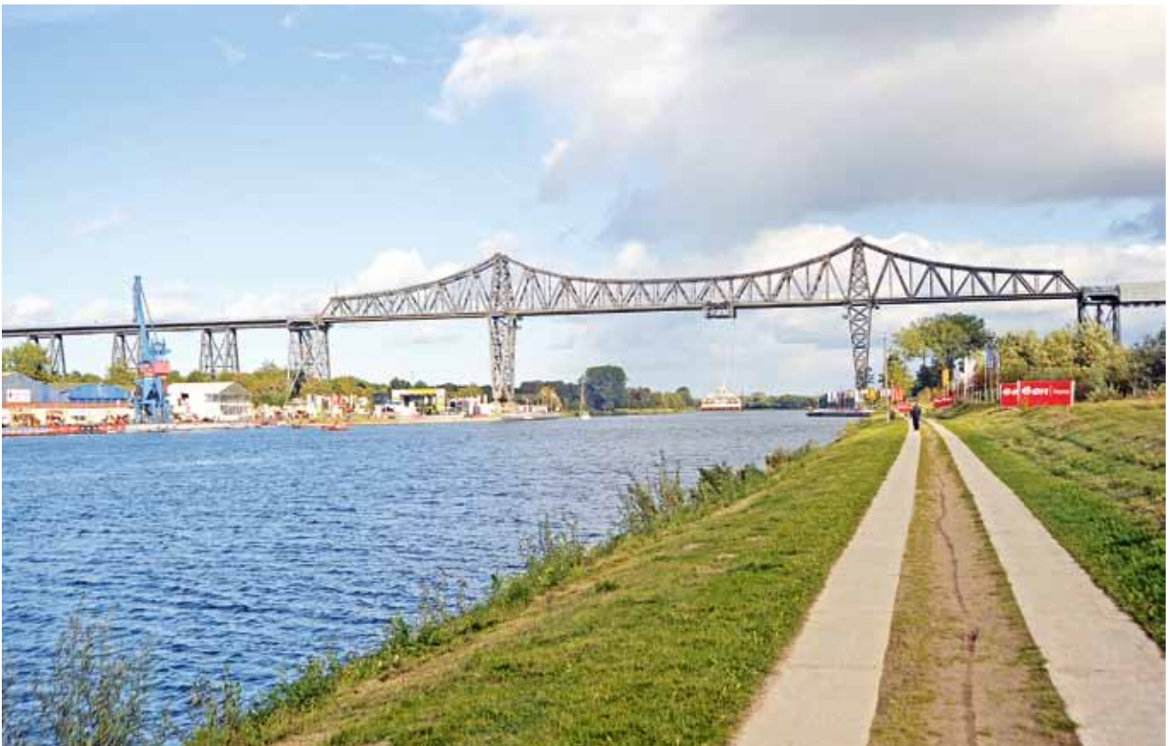
Abb. 4: Eisenbahn-Hochbrücke mit Schwebefähre über den Nord-Ostsee-Kanal (verbindet Rendsburg mit Osterrönhof)
