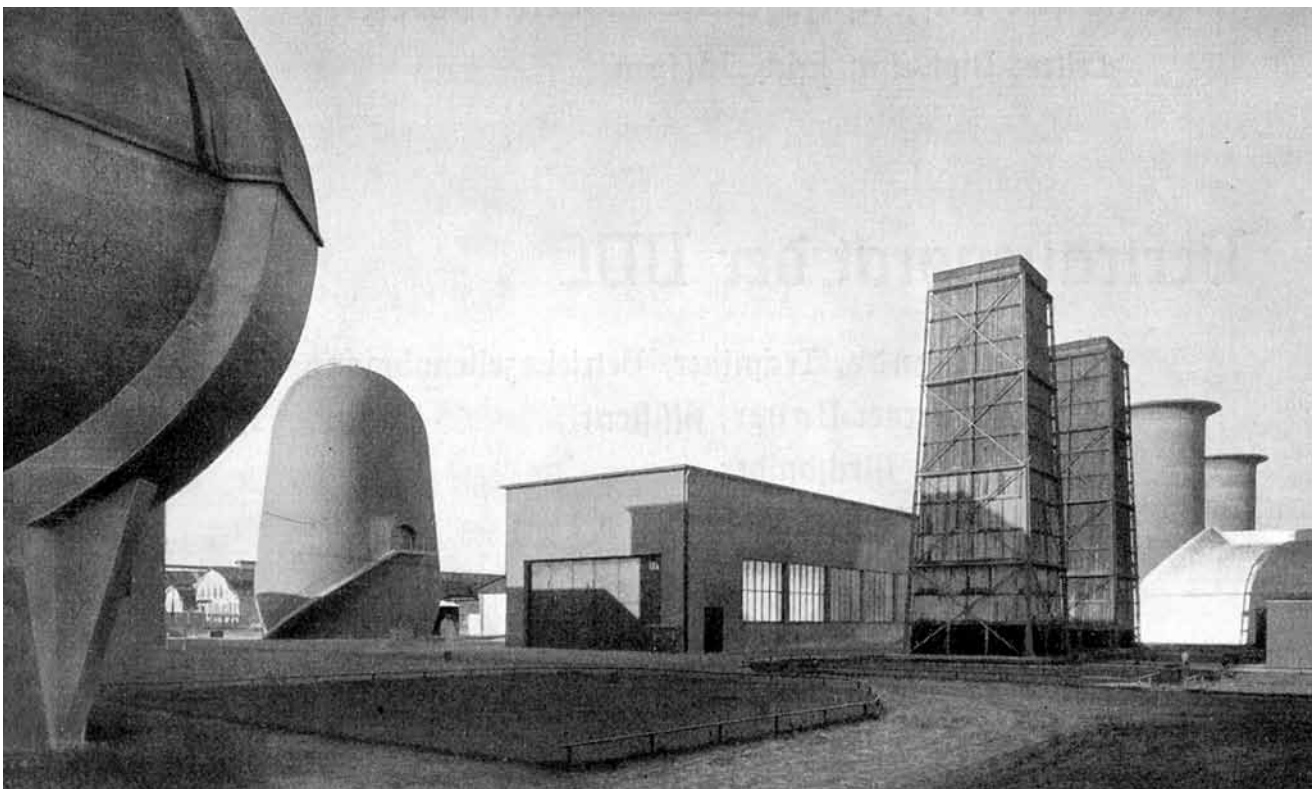
Abb. 1: Windkanal, Trudelturm und schalldämpfender Motorenprüfstand um 1935
