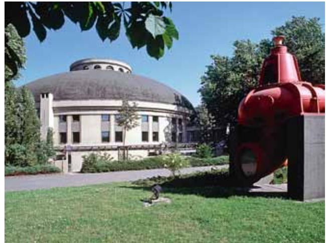
Abb. 2: Pumpwerk Duisburg „Alte Emscher“, 2010
