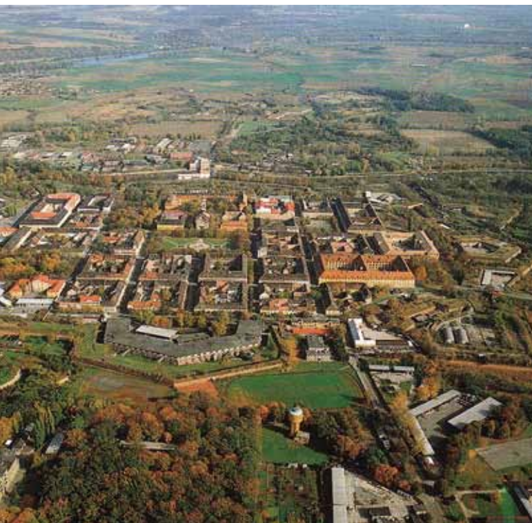
Abb. 3: Terezín von Westen, Luftaufnahme um 2000
