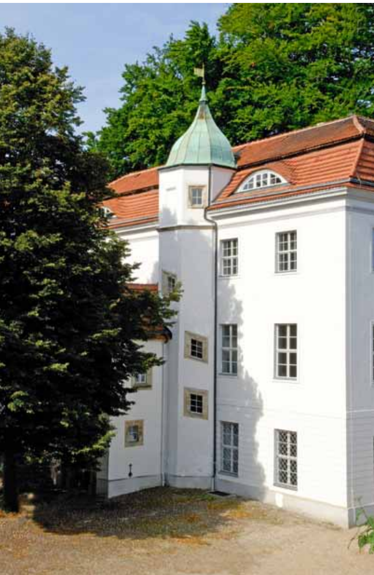
Abb. 1: Berlin, Jagdschloss Grunewald, Ansicht mit Treppenturm, 2008
