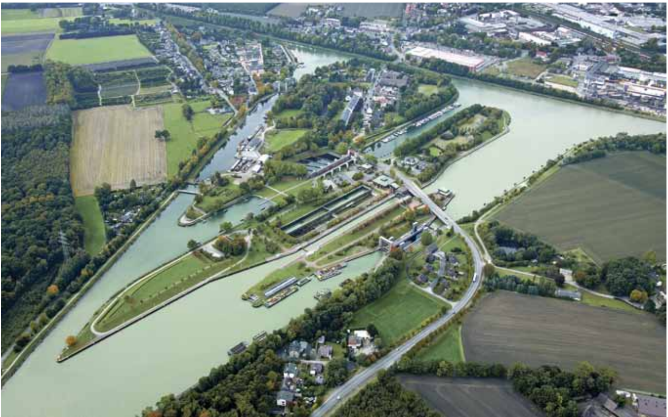
Abb. 1: Luftaufnahme der parallel angelegten Hebewerke und Schleusen Henrichenburg von Nordosten. Im Vordergrund das Neue Schiffshebewerk (1962), links daneben die Neue Sparschleuse mit Sparbecken (1989) und die Alte Schacht- und Sparschleuse (1914), ganz links im Hintergrund das Alte Schiffshebewerk (1899), davor der Museumshafen mit Werft
