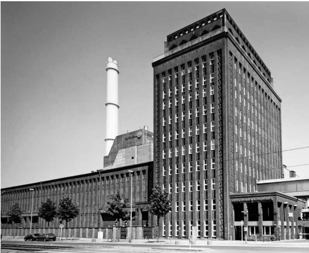
Abb. 3: Kraftwerk Klingenberg in Berlin-Rummelsburg, 1925–26 von Walter Klingenberg und Werner Issel, Aufnahme 2008
