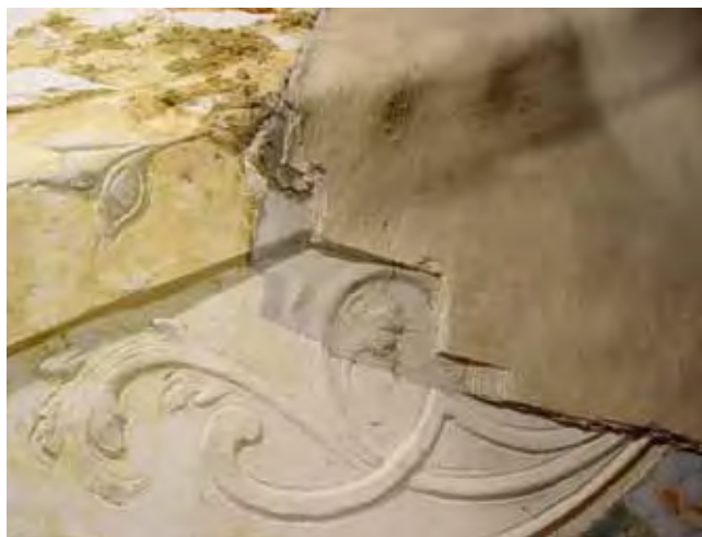
Abb. 1: Kartause Mauerbach, Bibliothek Vorraum, Stuckdecke mit Übertünchungen, Schichttreppe (BDA Mauerbach)
