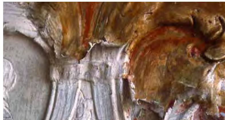
Abb. 8: Garsten, OÖ, ehem. Stift, Abtkapelle, Stuck von G. B. Carlone 1687 während Leimstrappofreilegung (Prof. Helmut Berger 1987)
