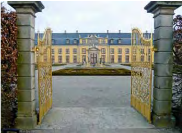
Abb. 27: Herrenhausen, Galeriegebäude, Gartenansicht, Zustand 2009, zehn Jahre nach der umfassenden Instandsetzung der Dachwerke und der Sicherung der stuckierten Flachdecke
