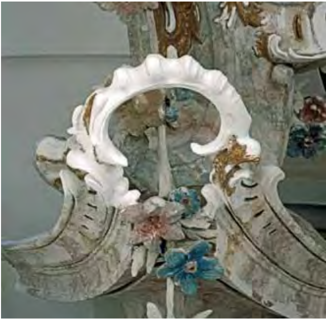
Abb. 8: Nördlicher Seitenaltar, Stuckergänzungen an einem Rocaillebogen
