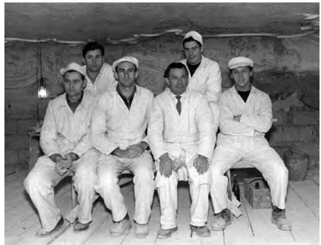
Abb. 5: Josef Schnitzer (mit Krawatte) im Kreis von Mitarbeitern unter der in Arbeit befindlichen Decke des Paradeschlafzimmers der Reichen Zimmer (Raum 60), wohl Ende 1957 (Bayerische Schlösserverwaltung)
