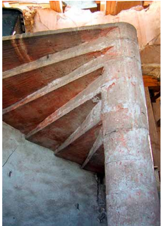
Abb. 8: Heringen a. d. Helme, Schloss, Wendeltreppe aus Gips-Kunststeinen
