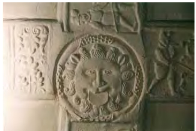
Abb. 12: Schmalkalden, Schmiedhof 19, Detail eines gestempelten Löwenkopfes an der Stuckdecke im ersten Obergeschoss
