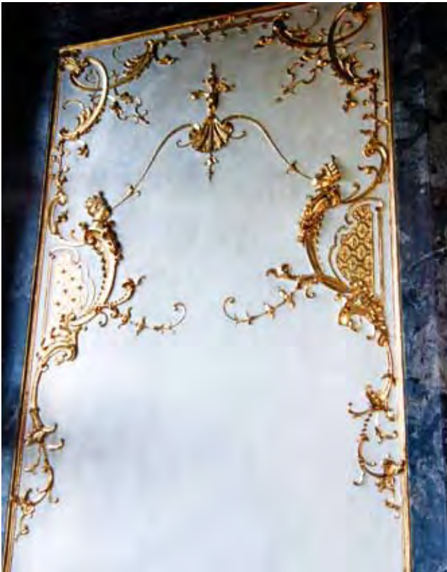
Abb. 8: Stuck in der Fensterleibung des oberen Geschosses der Hofkirche
