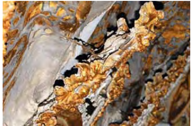
Abb. 10: Spiegel mit vergoldeter Stuckrahmung und Befestigung an der Gewölbeschale
