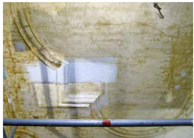
Abb. 16: Schloss Thalheim, Muster (Pilotfläche) zur Restaurierung in Kalktechnik, nach vorangegangener Kompressenbehandlung und Salzverminderung
