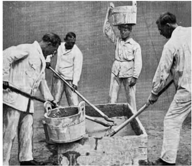
Abb. 3: Anrühren von Gips- oder Kalkmörtel
