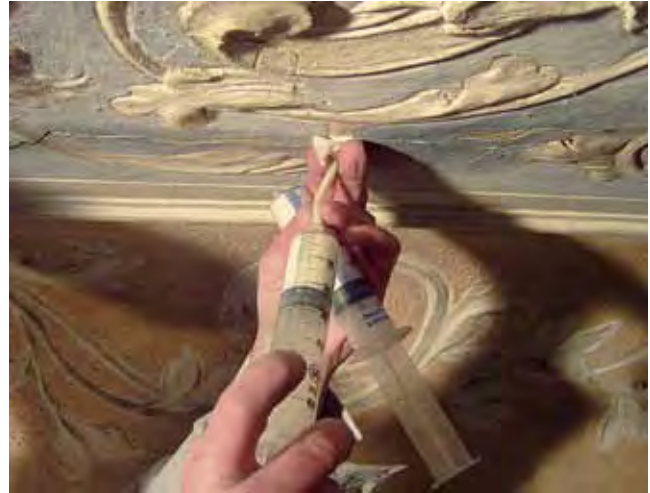
Abb. 10: Stuckrestaurierungsseminar 2008, Schloss Stettldorf, Niederösterreich, Hinterfüllung mit Kalkmilch (BDA Mauerbach)
