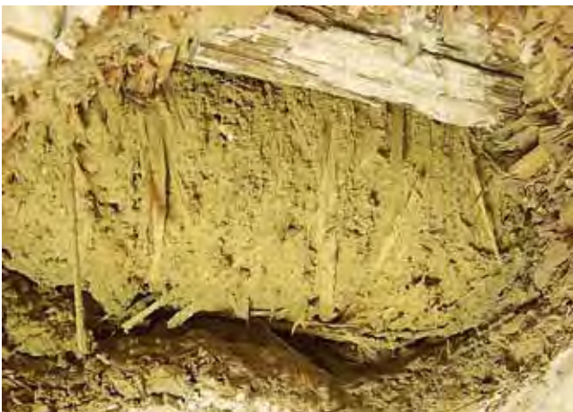
Abb. 3: Lehmwickel zwischen den Balken
