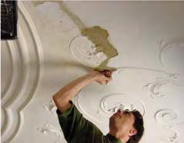
Abb. 9: Kartause Mauerbach, Nordtrakt, Stuckergänzung in Kalkmörtel (BDA Mauerbach)
