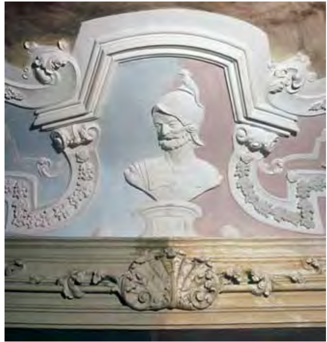
Abb. 11: Pommersfelden, Lkr. Bamberg, Schloss Weißenstein, Treppenhaus, während Restaurierung, rechte Seite Originalfassung, freigelegt und gereinigt
