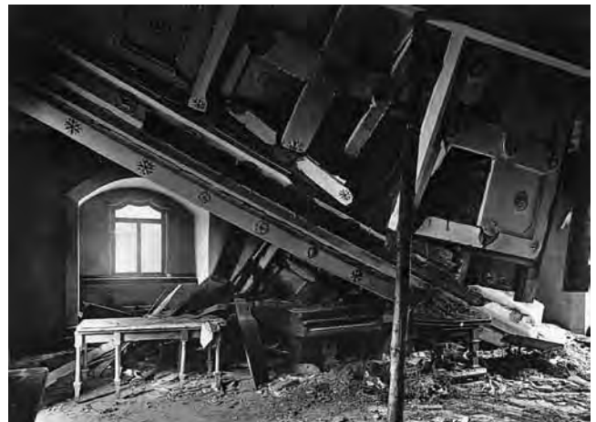
Abb. 15: Netzschkau, Schloss, Modelstuckdecke im großen Saal nach dem Einsturz 1945
