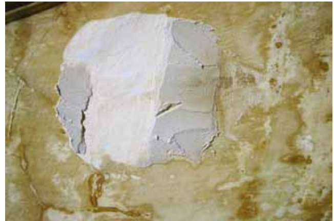
Abb. 15: Schloss Thalheim, Ammoniumcarbonat-Kompressenbehandlung mit positivem Reinigungsergebnis und Reduzierung oberflächlich vorgeschwitzter Gipsinterkruste
