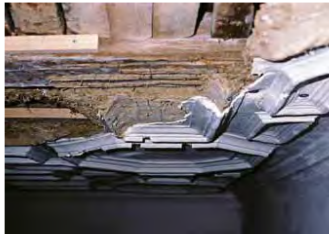
Abb. 13: Lehmstuck, Stuckaufbau
