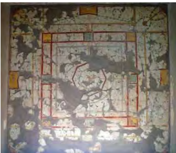
Abb. 11: Villa Oplontis, Durchgangshalle, Decke mit geometrischem Gliederungssystem (2008)
