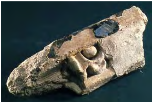
Abb. 6: Technologische Sammlung, Amtswerkstätten des BDA, Wien-Arsenal: Stuckprofil Eierstab um 1630, ehem. Stiegenhaus des Alten Borromäums in Salzburg (1973 abgebrochen)
