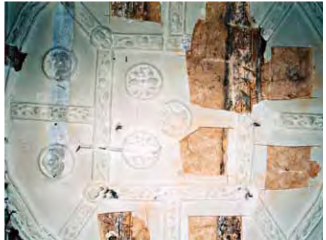
Abb. 14: Roschütz, ehem. Schloss, Modelstuckdecke mit ausgesägten Motiven kurz vor deren Abbruch 2002
