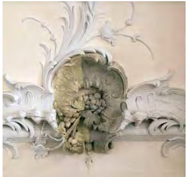
Abb. 16: Sünching, Lkr. Regensburg, Schloss, von François Cuvilliés 1758–1762 umgebaut, Festsaal, Stuckdetail mit alter Leimfarbenfassung (grau) und dem gelblich-grünen Zustand nach Abnahme der grauen Leimfarbe, bewirkte zunächst die irrtümlich (!) Interpretation der ursprünglichen Fassung als helles Grün; im Umfeld die Neufassung
