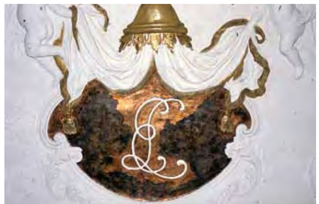
Abb. 5: Detail der Stuckdecke von 1705 im Forstamt von Stockach (Foto: Landesamt für Denkmalpflege Esslingen, Januar 2002)
