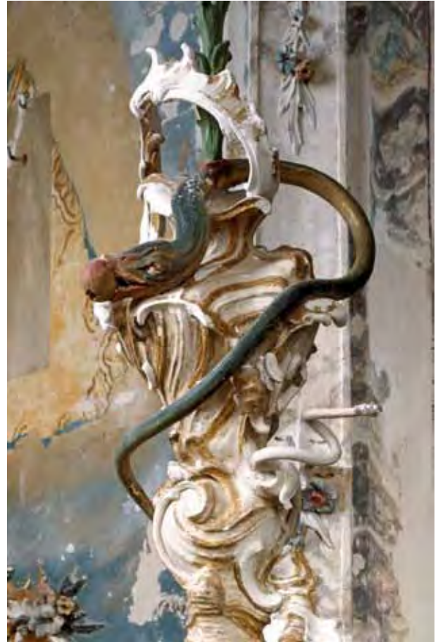
Abb. 12 und 13: Vase der Lilie vom nördlichen Seitenaltar und Vase mit Agave vom südlichen Seitenaltar nach Reparatur und Ergänzung der geschädigten Stucksubstanz
