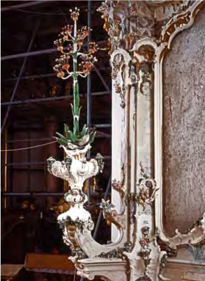
Abb. 12 und 13: Vase der Lilie vom nördlichen Seitenaltar und Vase mit Agave vom südlichen Seitenaltar nach Reparatur und Ergänzung der geschädigten Stucksubstanz
