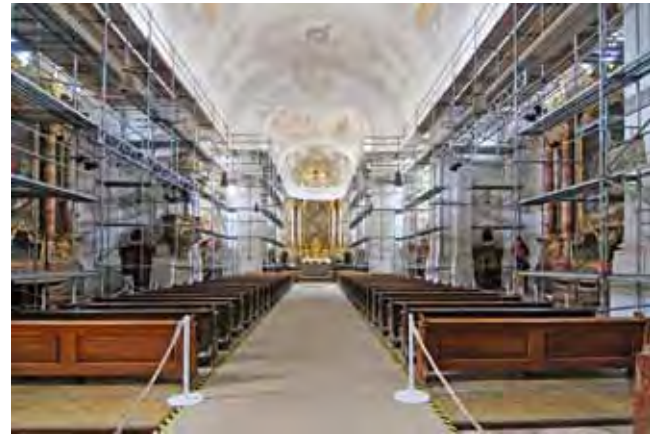
Abb. 21: Schäftlarn, Klosterkirche, Blick in das Langhaus, Schutznetze mit einer Maschenweite von 5x5 cm, Verankerung der Netze mit Schwerlastdübel und umlaufenden Stahlseilen
