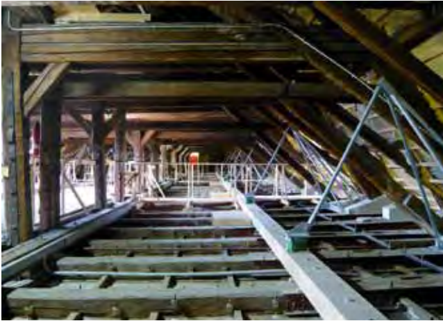
Abb. 35: Herrenhausen, Galeriegebäude, Blick nach Norden in den Dachraum, Zustand 2009
