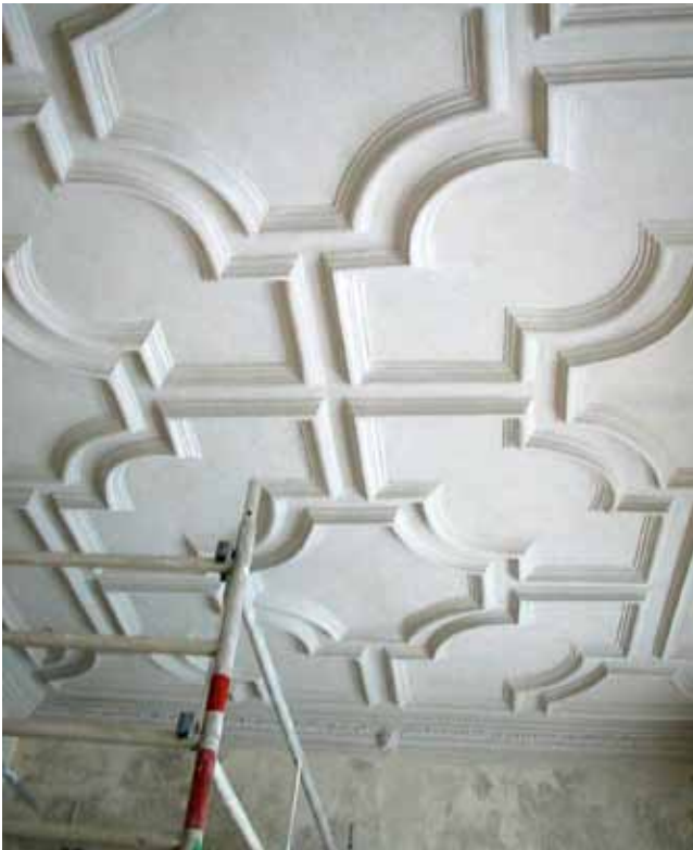
Abb. 7: Schloss Höchstädt, Deckenstuckaturen, erstes Drittel 17. Jahrhundert, Zustand während der Restaurierung (2004/2005)
