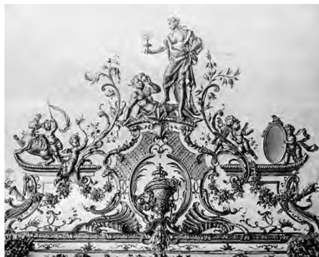
Abb. 6: Musterbearbeitung der Deckenhohlkehle des Spiegelkabinetts (Raum 61) durch Fa. Schnitzer, Juli/August 1957. Gut sichtbar sind die lockeren Vorzeichnungen auf dem Grundputz, der – in Ergänzung spärlicher Originalbestände – mit Rahmen- und Rankenwerk bereichert wird.
