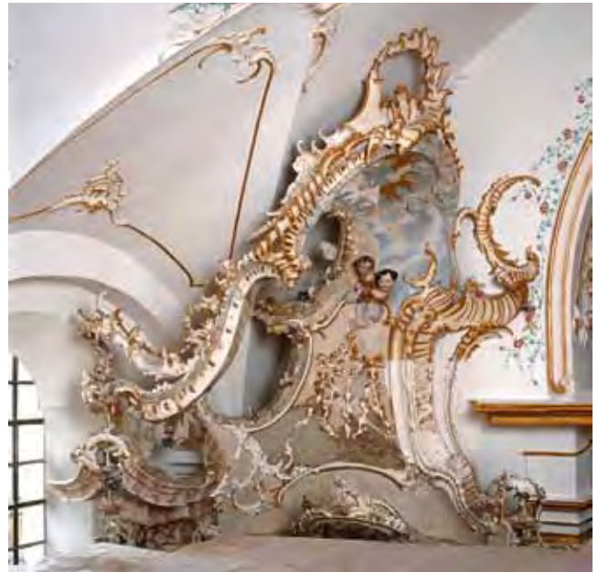
Abb. 3: Nördlicher Seitenaltar, Auszug nach Abschluss der Stuckreparatur mit Arbeitsprobe zur Farbfassung
