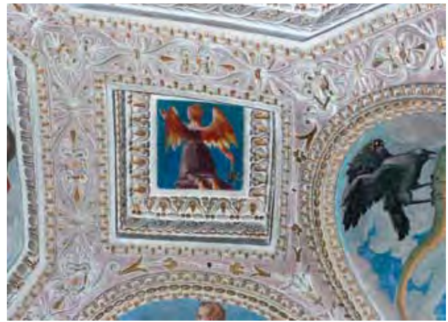
Abb. 5: Residenz Landshut, Sternenzimmer, Stuckspangen und Ecksituation
