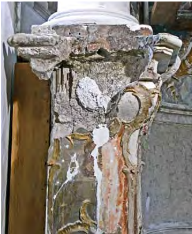
Abb. 4 und 5: Nördlicher Seitenaltar, Predella, Bereich unter der Säule vor und nach Ergänzung der Gesimsprofile und Antragsstückierung
