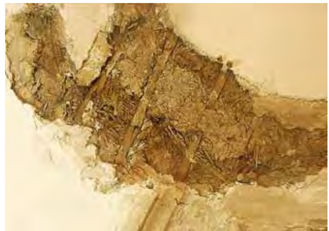
Abb. 4: Balken mit aufgenagelten Ruten
