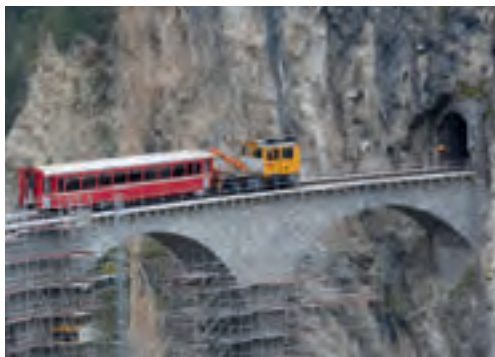
Instandsetzung Landwasserviadukt im Jahr 2009. (Bild: © RhB, Tibert Keller)
