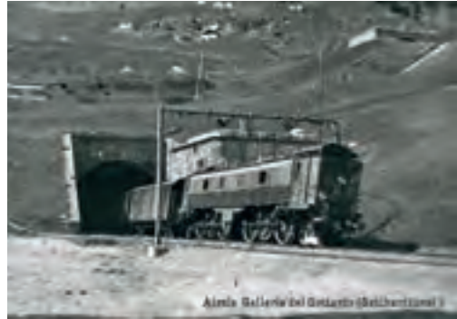
Das Tunnelportal in Airolo war stark befestigt und hatte eine unterirdische Verbindung zum Forte Airolo.
