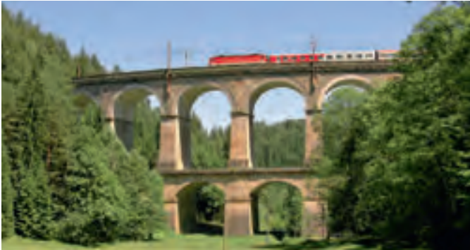
Brücke der Semmeringbahn. (Bilder: Rolf Höhmann)
