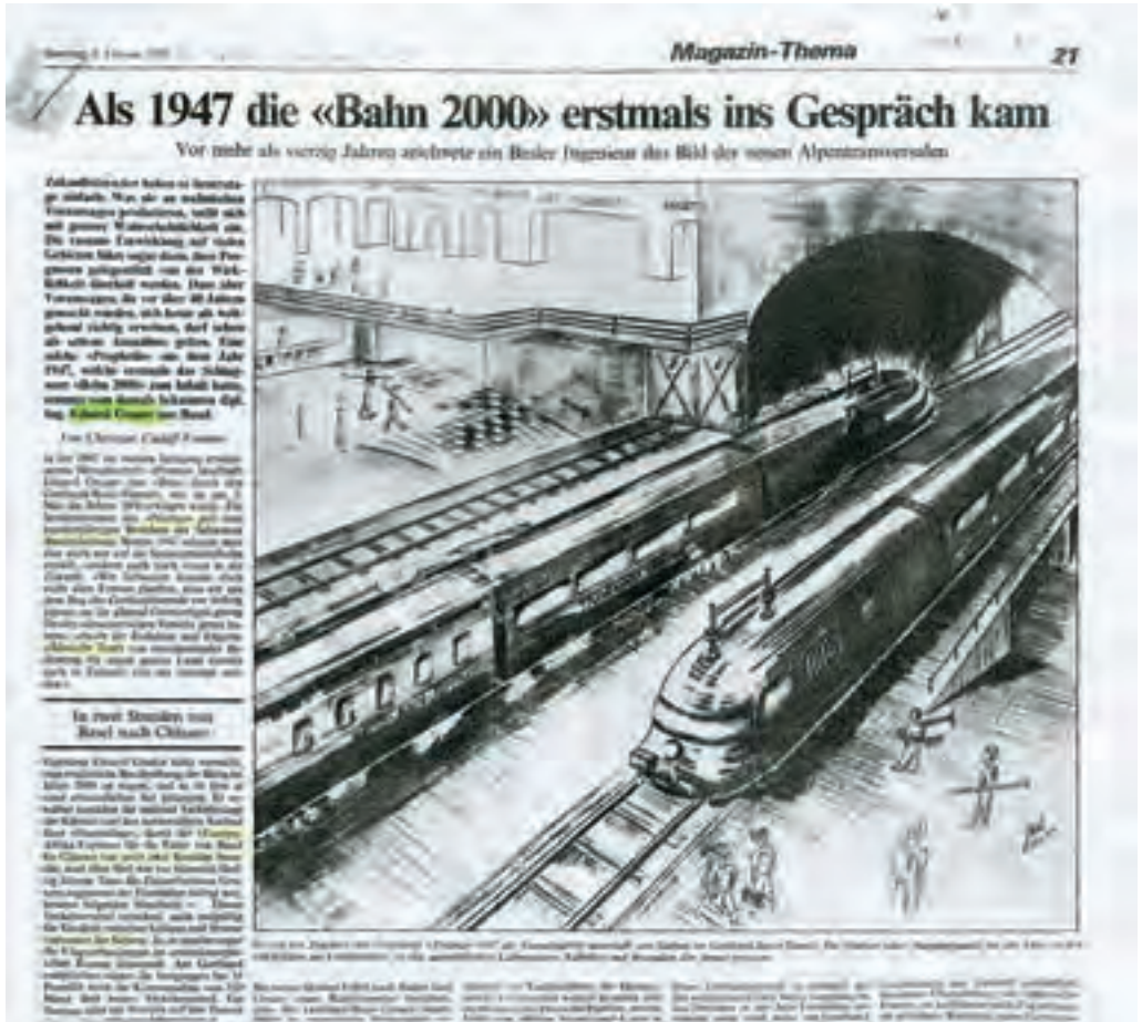
Der Zeit voraus: Das von Ingenieur Eduard Gruner 1947 vorgeschlagene Projekt «Europa-Afrika-Express» aus einem Rückblick der Bündner Zeitung vom 3. Mai 1990.
