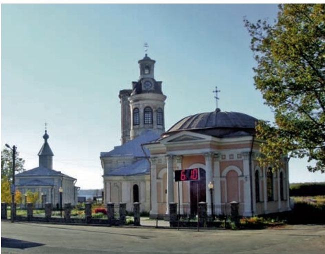
75. Ансамбль церквей в историческом центре Шлиссельбурга (004). 2010
