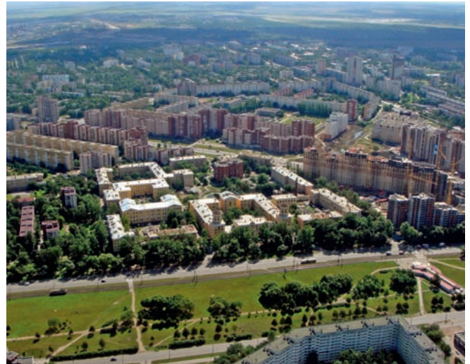
104. Дача графа К.Е. Сиверса («Кировский городок») в окружении современной застройки. 2007
