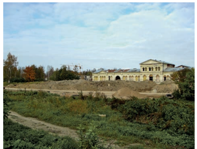
113. Михайловка. Конюшенный корпус в ходе реконструкции (015). 2010
