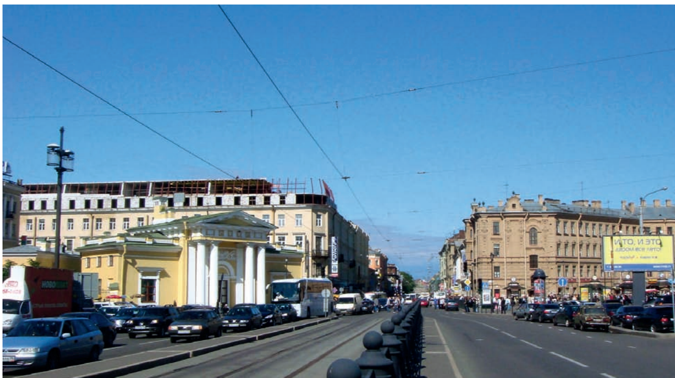
68. Дом на Сенной площади, искажаемый надстройкой (001d). 2008
