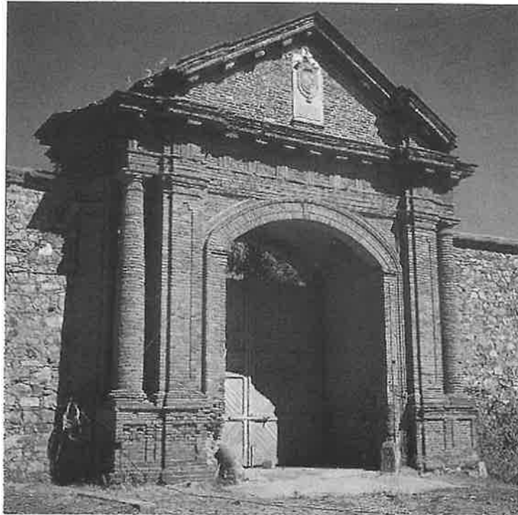
Puerta monumental de Carlos IV. Antiguamente era el acceso principal al Cerco Buitrones
