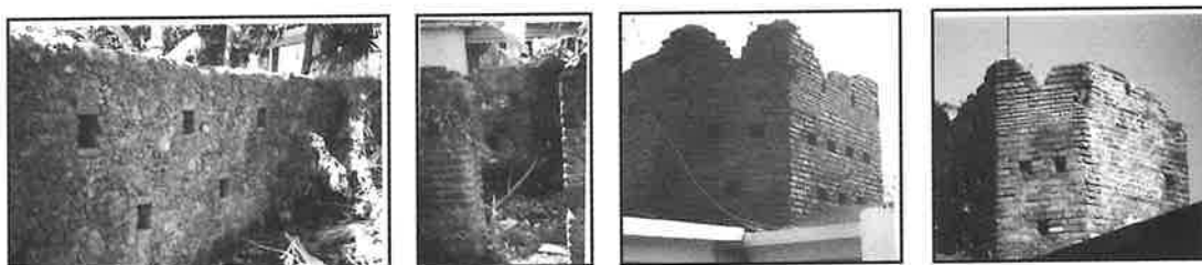
Torre viga Soledad de Doblado, Camino a Córdoba
