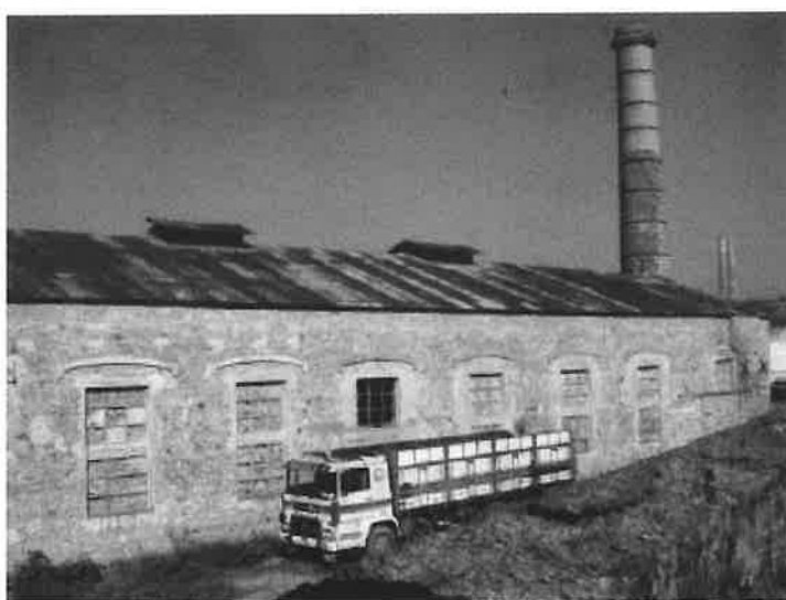
Almacén de plomo Fundición La Tortilla.
