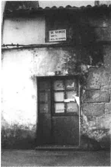
Adquisición del inmueble para su restauración. Años 90
