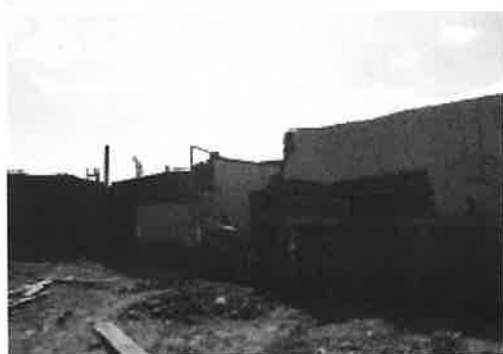
Torre este y muro noreste
