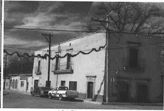
13. Casa de Orozco
