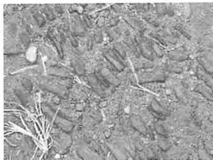
Revêtement au sol à l'aide des tessons de poterie. Une technique du milieu
