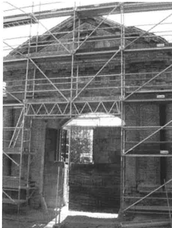
Restauración año 2004. Se aprecia la sustitución de la puerta de madera por una de metal
