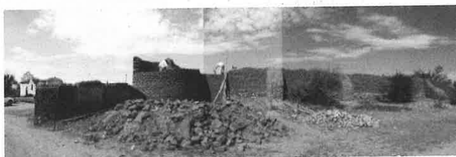
Torre este y muro noreste
