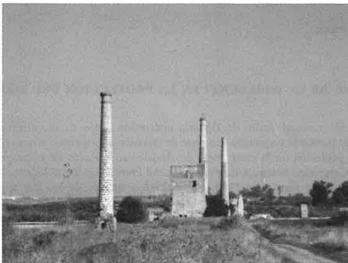
Chimeneas y casas de máquinas de la concesión Lord Derby.
