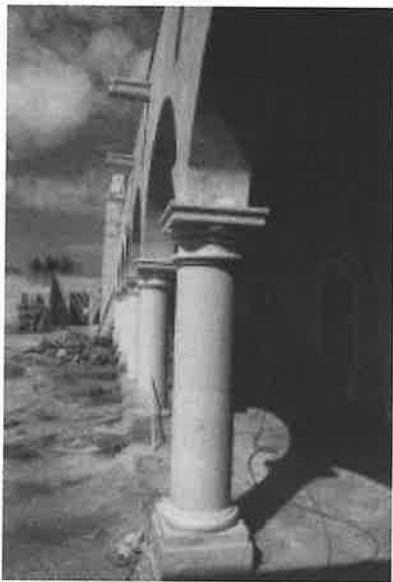
Arcada en patio interior
