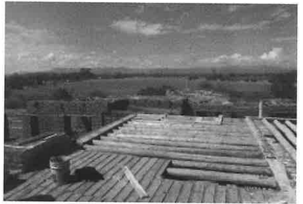
Ala sur y sustitución cubiertas
