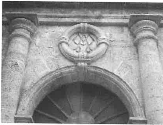
Detalle de clave en arco del templo
