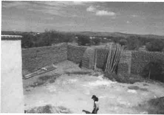
Torre oeste y muro noroeste
