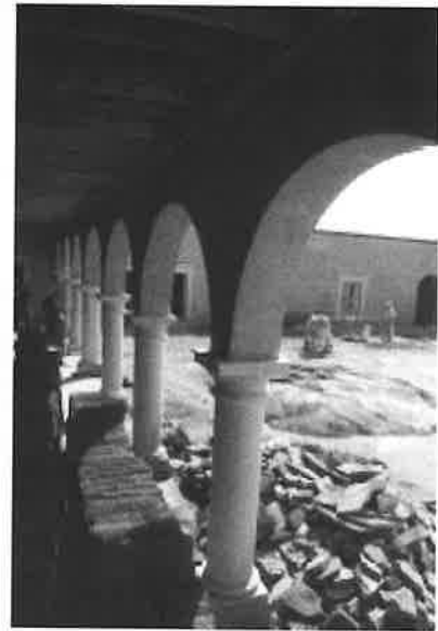
Arcada en patio interior
