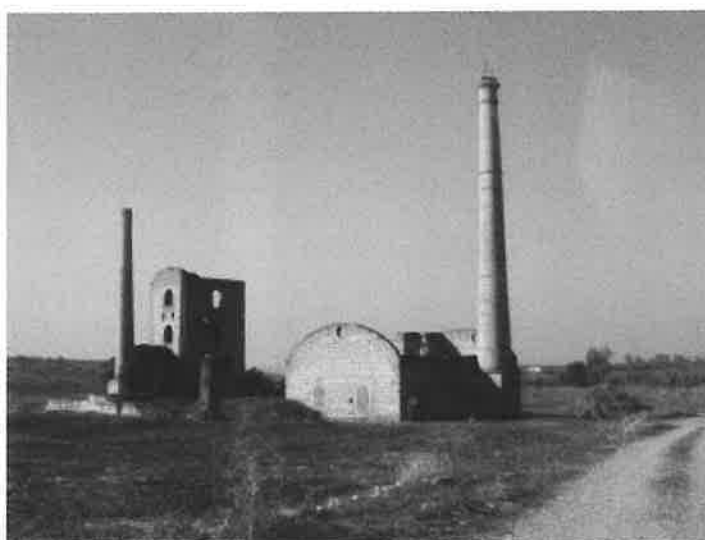
Chimeneas, casa de calderas y máquinas del pozo San Fedérico.
