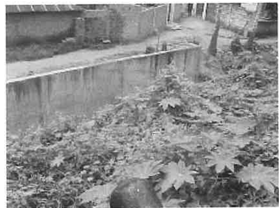
Vue sur la fosse côté Est
