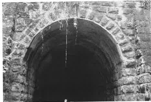
Bocas del tunel de Cambalache
