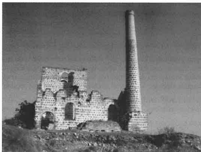
Chimenea y casa de calderas y de máquinas del pozo Santa Annie.
