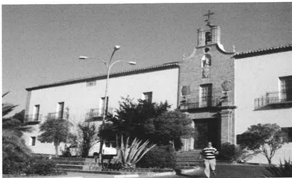
Real Hospital Minero de San Rafael. Almadén (Actual sede del Archivo Histórico de las Minas de Almadén y del Museo del Minero)
