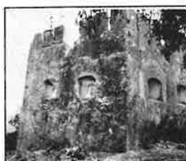
Torre viga Plan del Río, camino a
