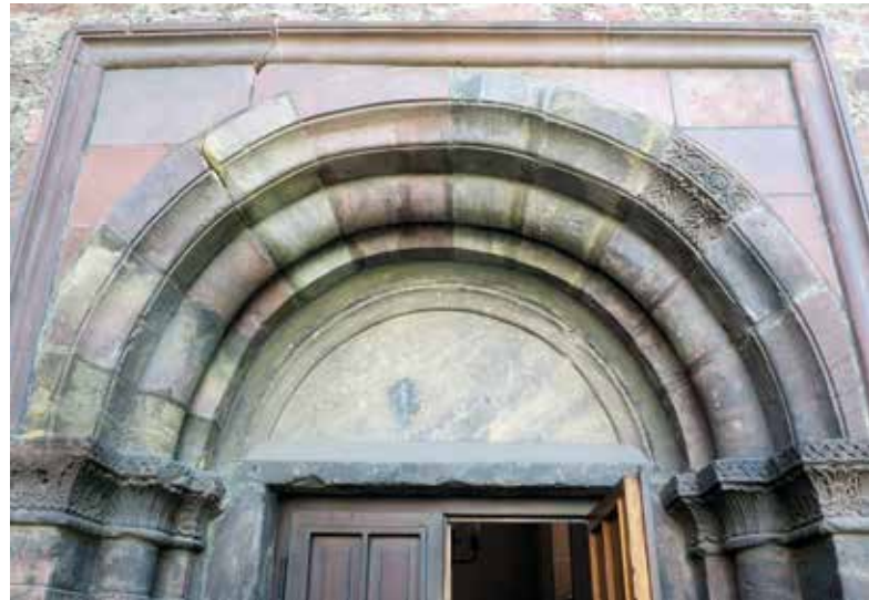
Abb. 19 Synagoge Worms, Eingangportalbogen: Der Wiederaufbau der im Novemberpogrom 1938 in Brand gesteckten Synagoge erfolgte 1956–1961 weitgehend in der Form des zerstörten Vorgängerbaus über den Grundmauern des Altbaus und unter Verwendung geborgener Steine und Bauteile (Foto ICOMOS Deutschland, J. Haspel)
