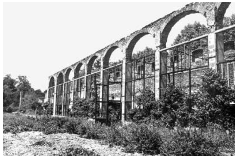
Abb. 7 Orangeriegebäude, Kriegszerstörungen, Südfassade von außen mit erhaltenen Fensterrahmen und Entlastungsbögen (Foto nach 1945, BSV, Fotosammlung Gärtenabteilung).
