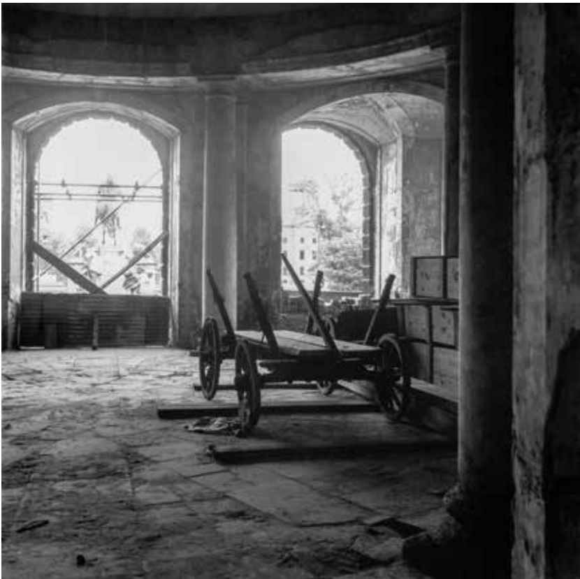
Abb. 8 Altes Schloss, Runder Vorsaal (Raum 115), Zustand nach 1952 (Foto SPSG, Fotograf unbekannt)
