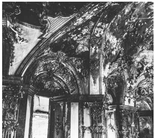
Abb. 7b Hofkirche: Ansicht der Emporen- und Gewölbezone nach Nordosten, Zustand um 1946, mit schweren Schäden an Malerei und Stuck (Bildarchiv Foto Marburg, B 886/11, Datum 1945–46)
