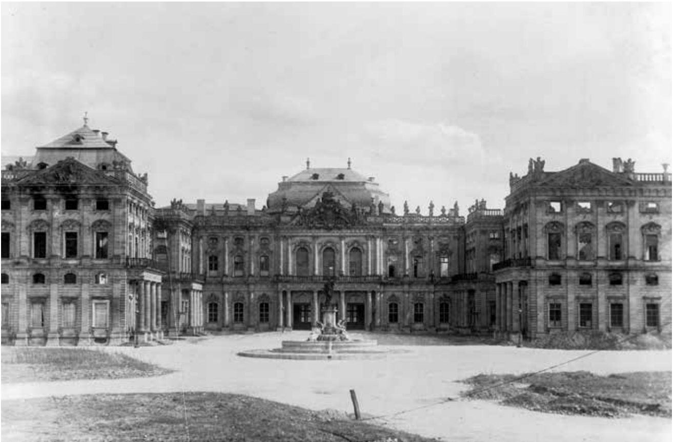
Abb. 2a Residenz Würzburg, Zustand 1947 mit teils fertiggestellten Dächern, Ansicht von Westen (Foto Bayerische Schlösserverwaltung)
