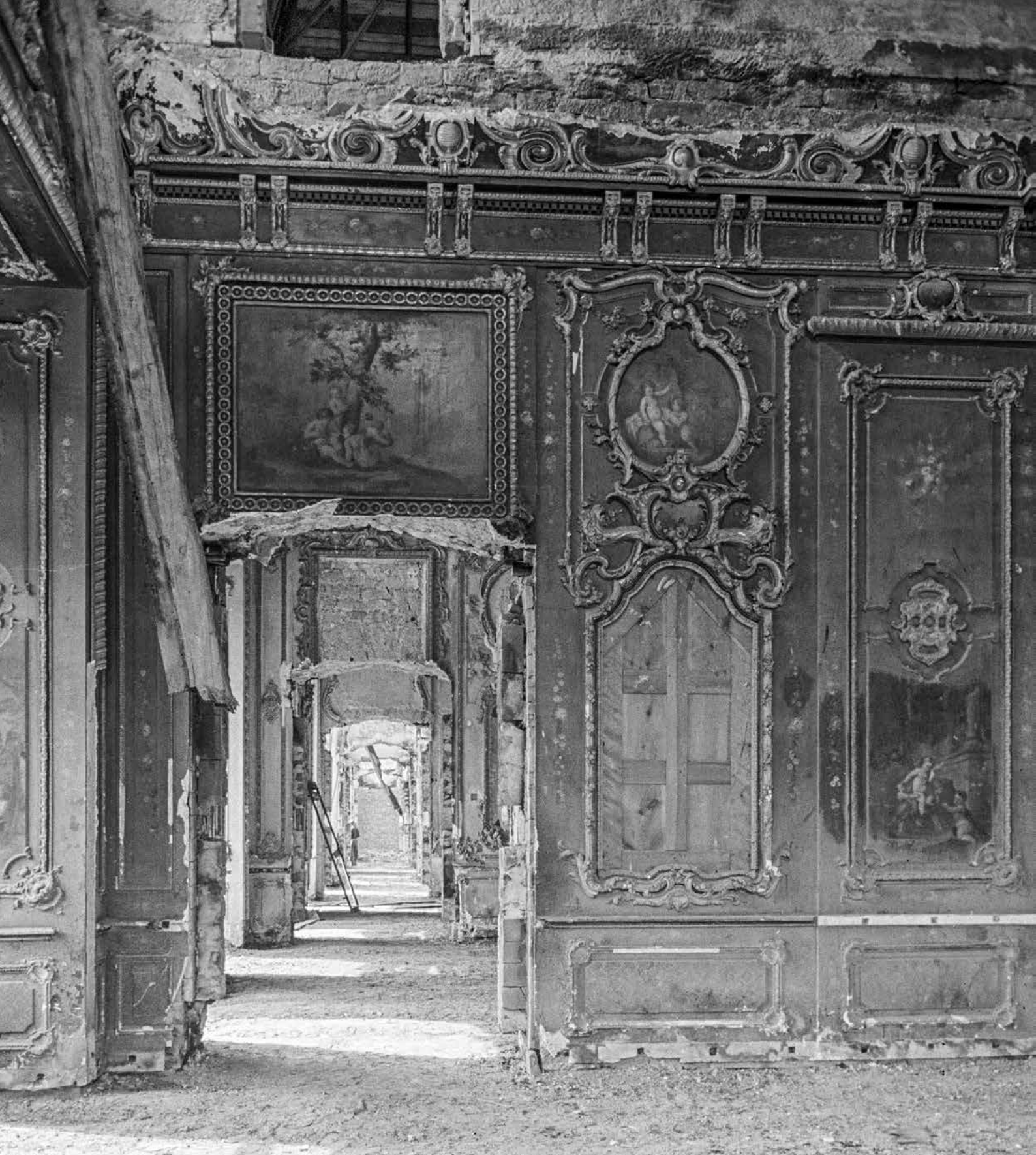
Tafel Va Residenz Würzburg, Nördliche Kaiserzimmer; Grünlackiertes Zimmer; Blick nach Süden, Zustand nach den Kriegszerstörungen, Aufnahme 1946 (Bildarchiv Foto Marburg, Fotograf unbekannt, Aufn.-Datum: 1946, Fotokonvolut Trümmerkampagne, LA 984/37)
