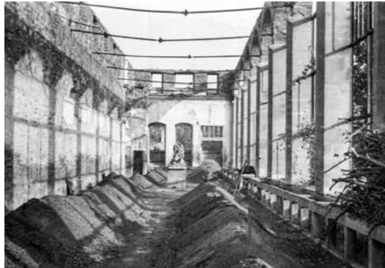
Abb. 6 Orangeriegebäude, Kriegszerstörungen, Innenansicht mit erhaltenen Außenmauern (Foto nach 1945, BSV, Fotosammlung Gärtenabteilung).
