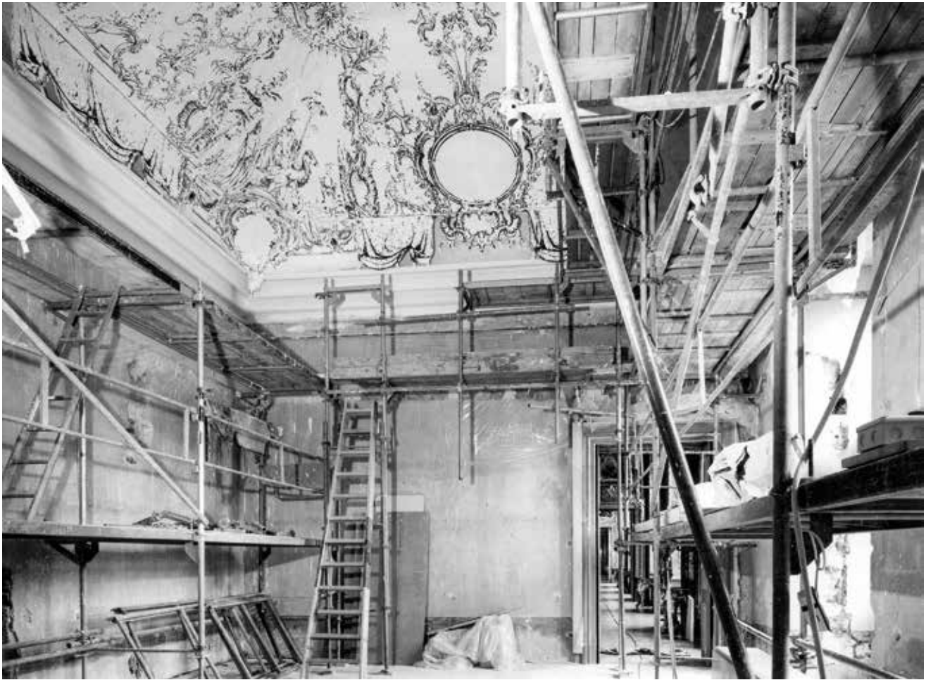
Abb. 7 Residenz Würzburg, Rekonstruktion der Decke des Spiegelkabinetts, mit Positionierung der Rekonstruktionszeichnungen, um 1981–82 (Foto Dorothea Zwicker, Würzburg)
