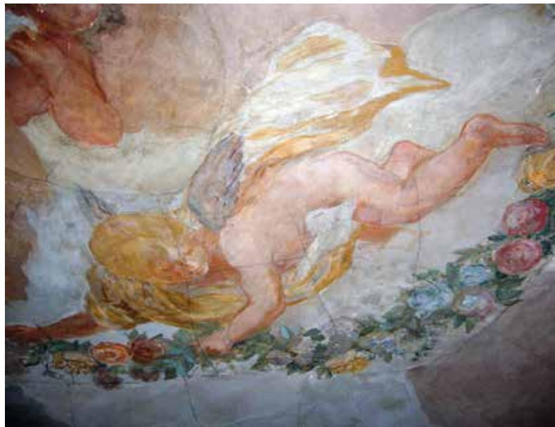
Abb. 8b Hofkirche: Mittelkuppel mit der „Krönung Mariens“, Teilansicht mit der vereinfachten malerischen Überarbeitung bzw. Ergänzung durch Karl Körner, 1959–62, Zustand 2010 (Foto U. Schädler-Saub, 2010)
