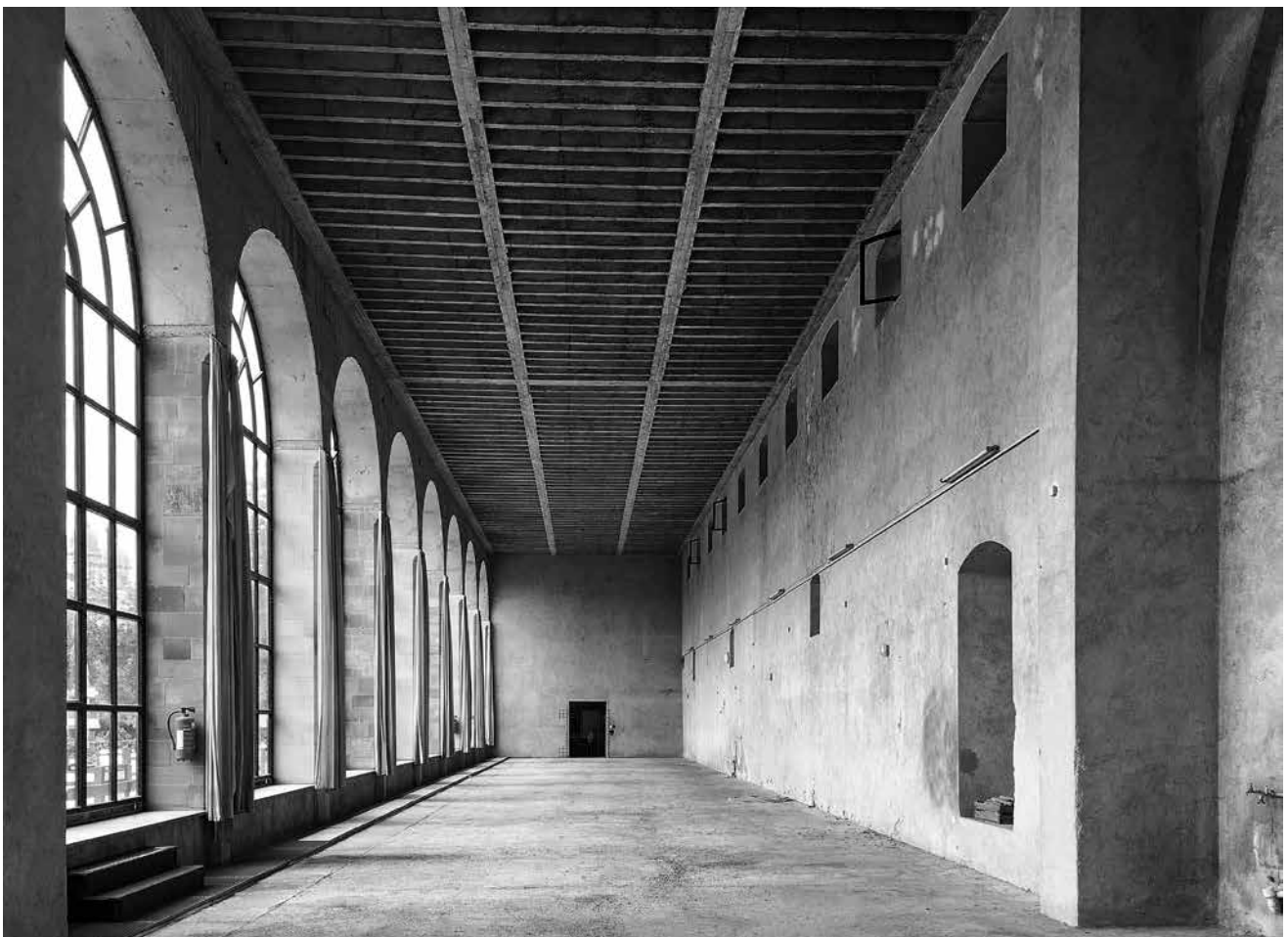
Abb. 9 Orangeriegebäude, Innenansicht nach Wiederaufbau (Foto 2021, Sebastian Väh, BSV, Gärtenabteilung)
