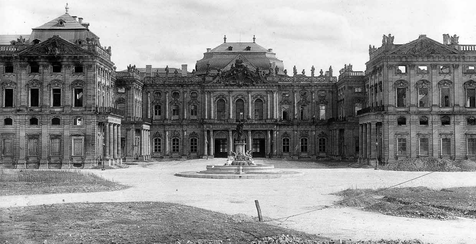
Abb. 8 Residenz Würzburg, Zustand 1947 mit teils fertiggestellten Dächern, Ansicht von Westen (Foto Bayerische Schlösserverwaltung)
