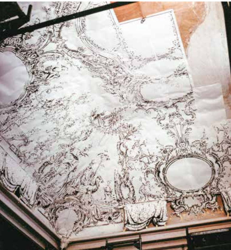
Abb. 5a Spiegelkabinett, nach Wiederherstellung des Muldengewölbes: vorbereitende Arbeiten für die Rekonstruktion des Deckenstücks von Antonio Bossi, mit Positionierung der Rekonstruktionszeichnungen, um 1981/82 (Foto Dokumentationsarchiv Bauabteilung BSV München)
