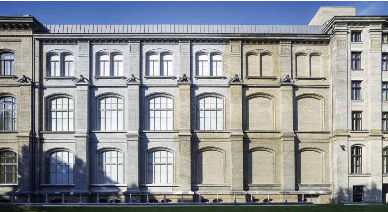
Abb. 22: Naturkundemuseum Berlin (August Tiede, 1875–1889): Wiederaufbau und Neuinterpretation der Kriegsruine des Ostflügels erfolgten nach ausführlicher Diskussion und Vorbereitung nach Plänen des Büros Diener & Diener Architekten in den Jahren 1995 bis 2010 für die Nass-Sammlungen des als Besucherdepot zugänglichen Magazintrakts; die in grauem Beton gegossene Schließung der Fehlstellen nimmt in Gliederung und Textur die Backsteinfassade der überlieferten Außenwände des Altbaus auf und setzt sich als Reparatur und Gegenwartsarchitektur vom historischen Baubestand ab (Foto C. Richters/Diener & Diener Architekten)
