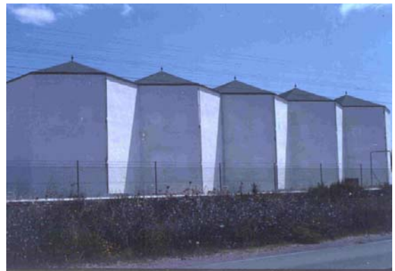
Nouvelles caves à Jerez de la Frontera
