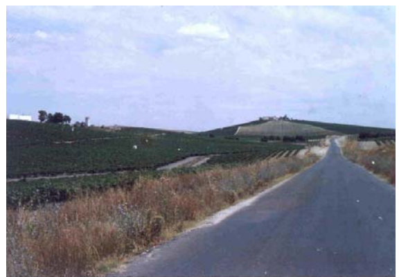
Route rectiligne sur les traces d'une voie romaine ; à gauche, bodega au milieu des vignes, Xérès
