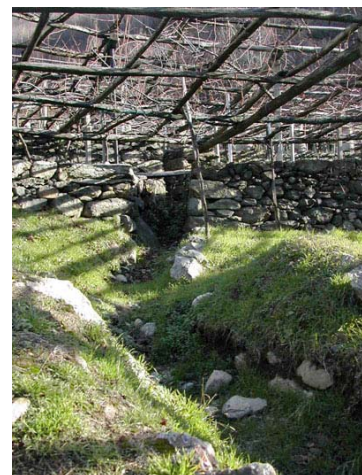
Il sistema di canalizzazione delle acque
