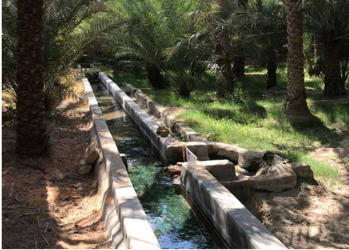
الشكل رقم 4: التقنية القديمة والمواد الحديثة - الجدران الخرسانية لقنوات الروافد (العوامد) والسدود البلاستيكية لأفلاج اليوم (ويغبولدوس، 2018).
