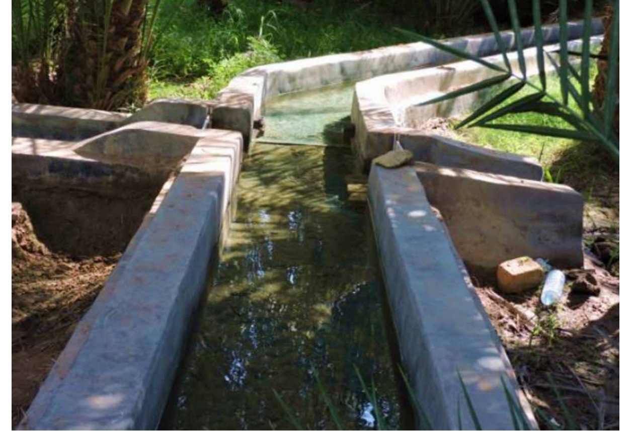
الشكل رقم 10: قنوات مصنوعة من الأسمنت تستخدم الآن لتوزيع المياه (هاروني، 2018).
