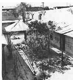
Vista previa de patio de residencia antes de la intervención (se observa piso cubierto por concreto)
