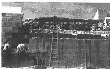
Las exploraciones evidenciaron la preexistencia de un "aporticado" y enchape de sillar
