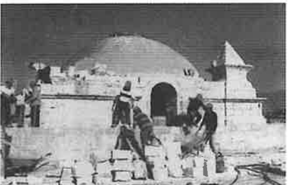
Consolidación y reconstrucción de elementos dañados y/o perdidos
