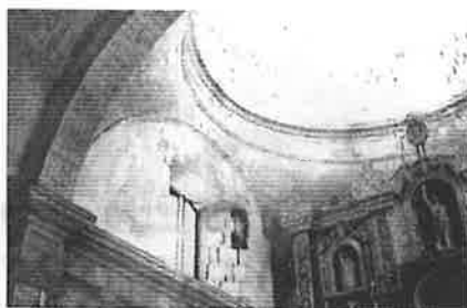
Paramentos dañados en el sector del presbiterio con virtual colapso de cúpula mayor
