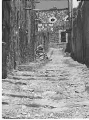
9. Alteración de vanos
