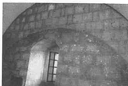
Reestructuración de muro de coro con sillar
