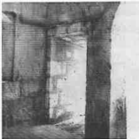
Paramento interior consolidado en estado natural
