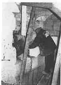
Trabajos sobre escalera de acceso al coro
