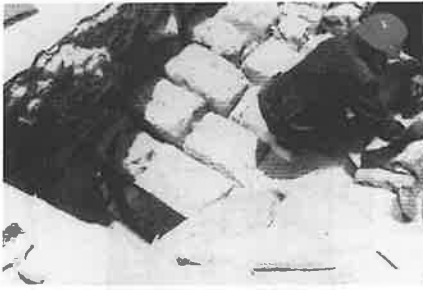
Trabajos a nivel del extradós sobre lunetos
