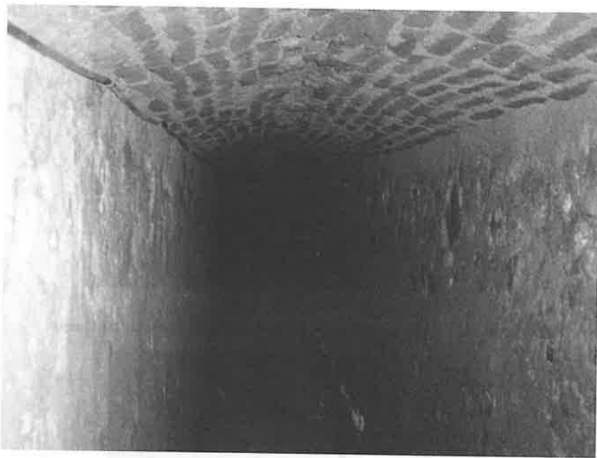
Galería que comunicaba con la Cárcel de Forzados
