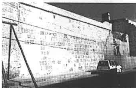
Vista de muro reconstruido (primera etapa) y obra preliminares en el muro vecino al Oratorio (2da. Etapa)
