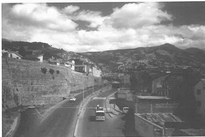
Foto No. 18 Vista del Viaducto 24 de Mayo que atraviesa el centro histórico de oeste a este.
