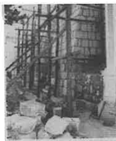
Proceso de consolidación. Muro del Evangelio
