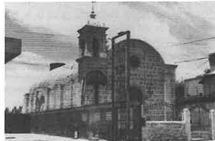
Muro de pies (cercado por el grifo y edificaciones inmediatas)
