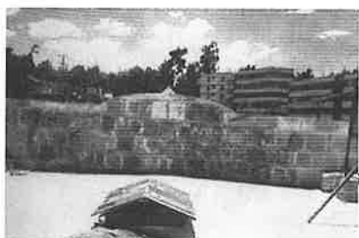
Desmontaje total de muro sobre arco fajón presbiterio
