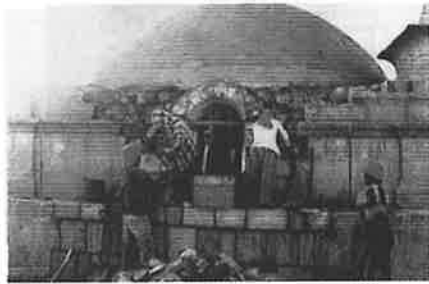
Trabajos preliminares en tambor de cúpula mayor
