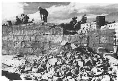
Liberación de carga y desmontaje de muro sobre arco fajón presbiterio
