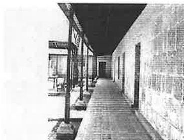
Acabado final de pisos
