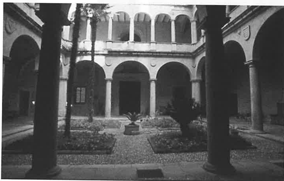
Palacio de los Duques de San Carlos (patio)
