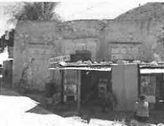
5. Entrada túnel de Ogario
