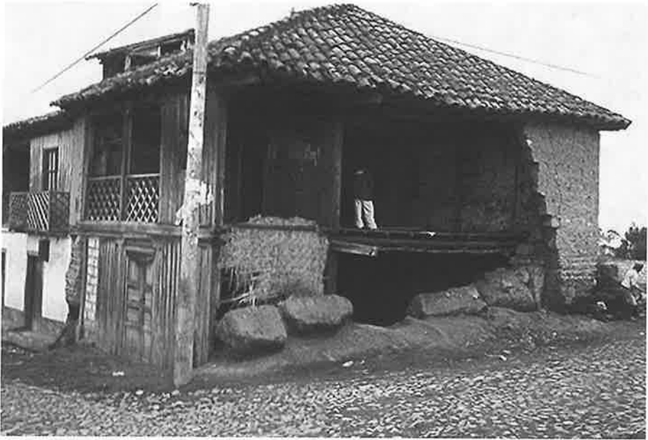
Foto No. 10 Estado de conservación
