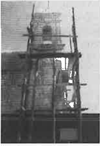
Apuntalamiento sobre torre (desde "grifo")
