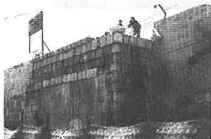
Asentado de piezas de la coronación
