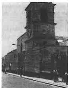
Muros de pies. Fachada y torre remozadas
