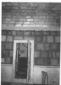
Vista del muro lateral del sotocoro
