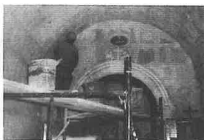
Consolidación de paramentos e intradós de capilla lateral
