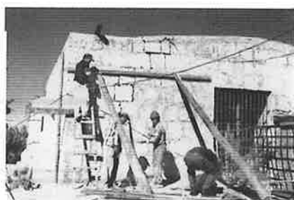
Apuntalamiento preventivo sobre muro testero
