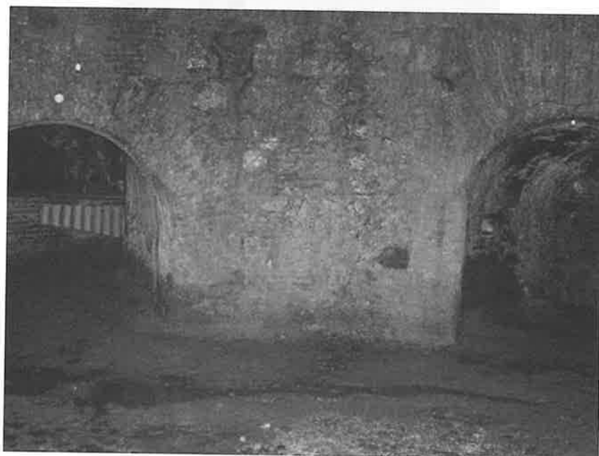
Baritel del pozo San Andrés. Minas del Castillo
