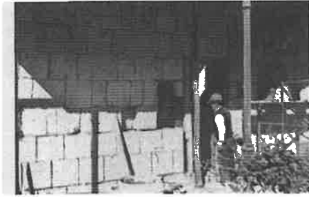
Juntas liberadas en paramentos exteriores
