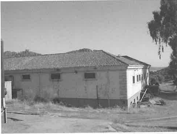
Almacén de mercurio
