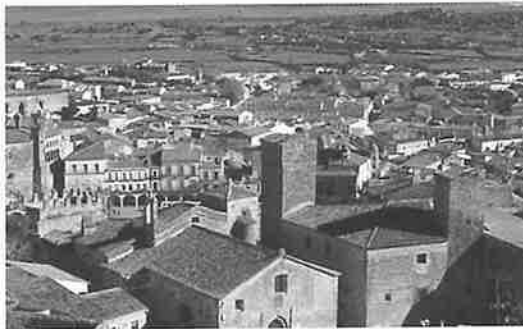
Vista general de la ciudad extramuros ("ciudad")
