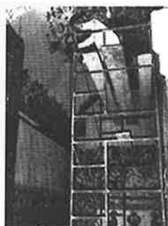
Aplicación de funguicida en el recubrimiento mural del Intradós de Oratorio
