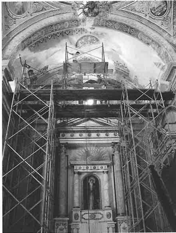
Trabajos de restauración en proceso
