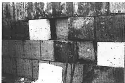
Detalle de calzadura en muros
