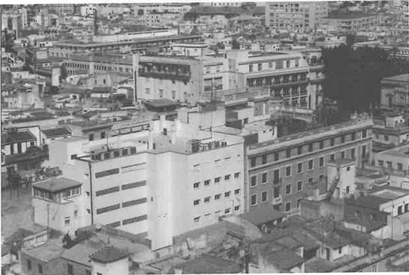
Figura 29. Discontinuidades volumétricas en la avenida de la Constitución
