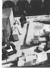
Taller de labrado y tallado de "sillar"
