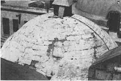
Liberación de carga hasta el extradós sobre cúpula
