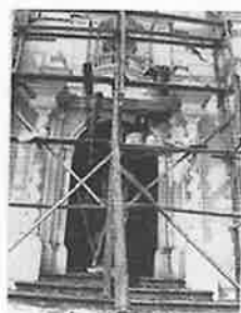
Andamiaje sobre muro de pies
