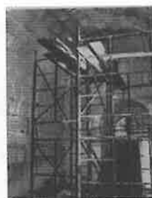
Consolidación final de capilla
