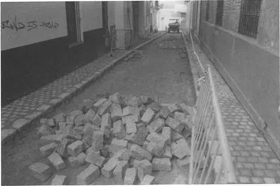
Figura 32. Renovación de pavimentos en torno a la iglesia de San Martín
