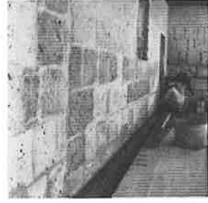
Paramentos consolidados y trazado de contra zócalo
