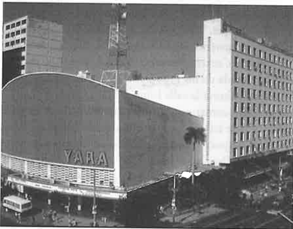
Edificio Radiocentro. Primer ejemplo de la modernidad
