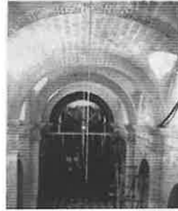
Consolidación final de bóveda de nave mayor hasta el transepto
