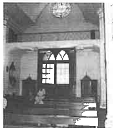
El coro y parte interna de muro de pies (después de la intervención)
