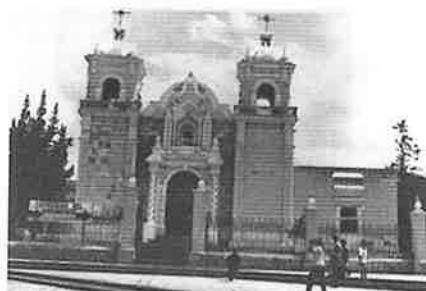
Vista final de muro de pies
