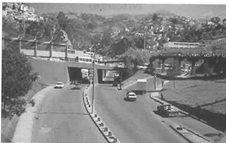
Foto No. 19 Confluencia de la avenida Occidental y Viaducto 24 de Mayo.
