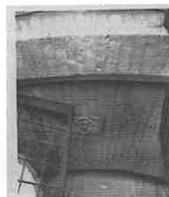
Exposición en estado natural del sillar en cubierta y paramentos de sotocoro
