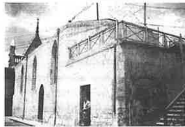
Vista de la parte posterior de la capilla
