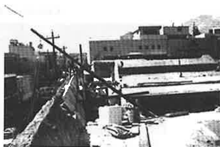
Coronación del muro
