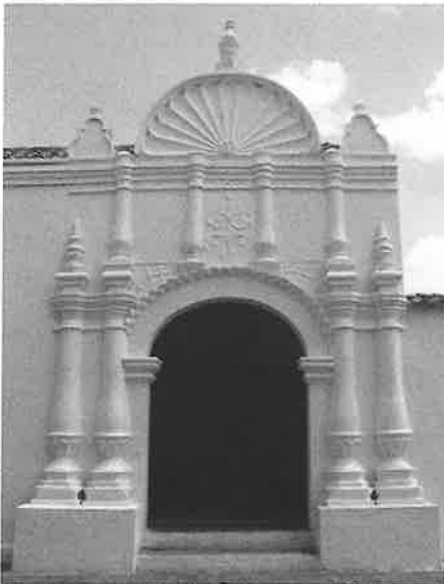
Portal Casa de Ventanas de Hierro
