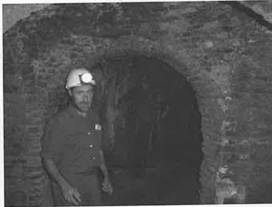
Mampostería al interior de la mina
