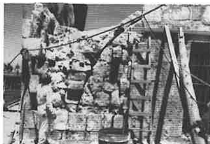
Desmontaje de sección de muro testero
