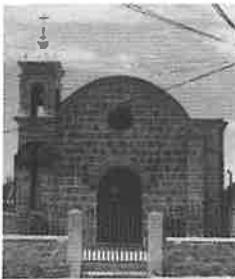
Muro de pies
