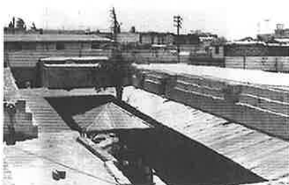
Vista aérea de stop (se observan los acabados de la cubierta en ambientes y la rehabilitación de la z
