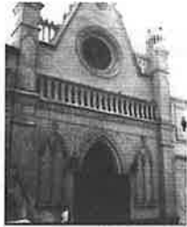
Muro de pies
