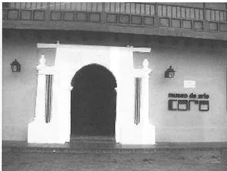
MAC después de la restauración
