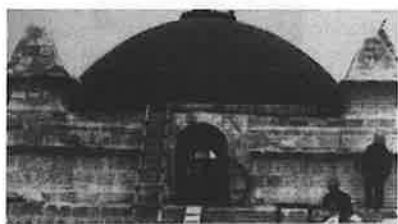
Restitución final del mortero impermeabilizante sobre cúpula mayor
