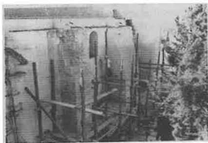
Andamiaje sobre muro del evangelio (se aprecia contrafuerte derruido)
