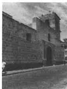
Muro de pies. Fachada y coronación
