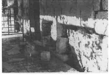
Calzaduras masivas en sector del paramento exterior, anteriormente ocupada por zócalo de concreto
