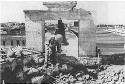
Liberación de carga sobre el primer tramo del presbiterio
