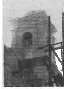
Trabajos específicos en el campanario
