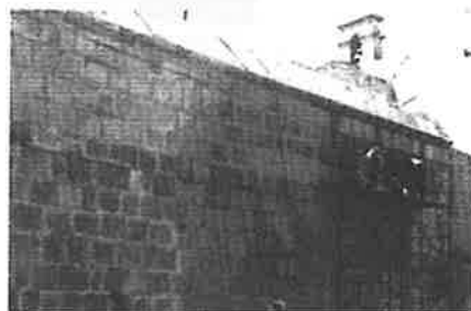
Restitución final del emboquillado
