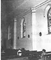
Paramento interior (después de la intervención)
