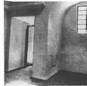
Paramento interior encalado
