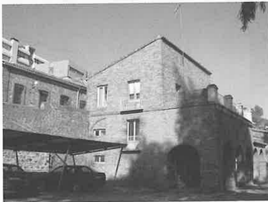
Antiguas oficinas administrativas
