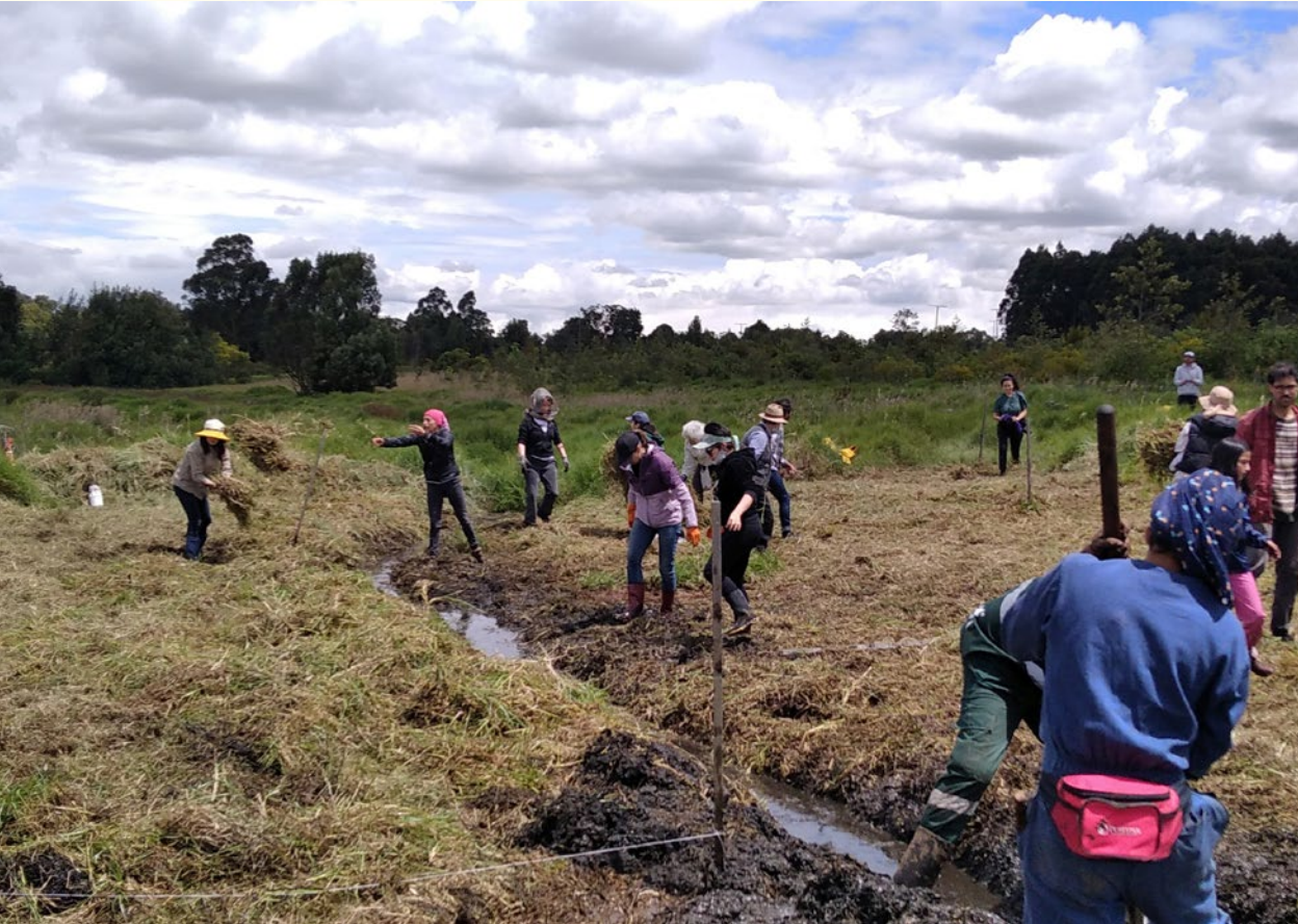
Inicio de actividades de construcción de los camellones de Las Mercedes, Reserva Thomas van der Hammen, Bogotá. Fotografía: Diego Martínez Celis, 2022.
