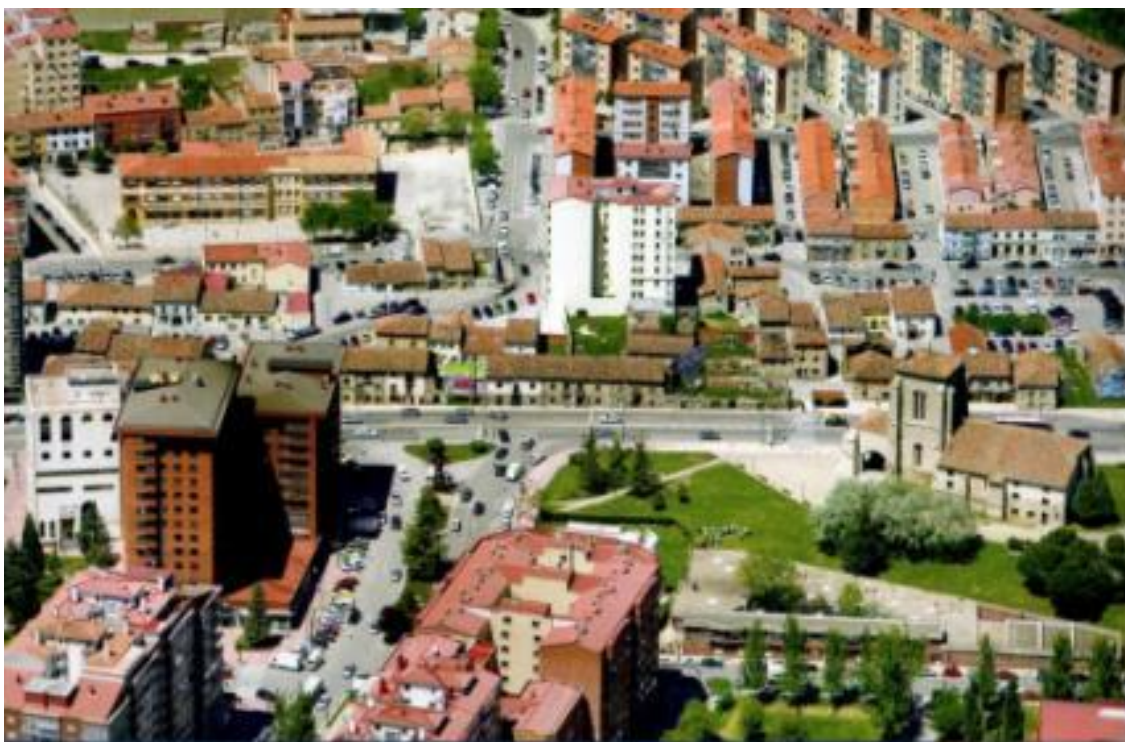
Fig.2 El pequeño núcleo de Gamonal con su iglesia de Santa María, a la derecha, se ha convertido en una carga para el “desarrollo urbano” de la ciudad, un estorbo para trazar una vía de circulación rápida transversal al
