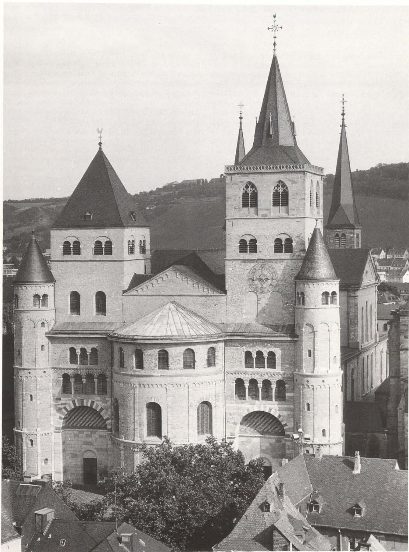
Abb. 57. Trier, Dom, Doppelturmfront mit Westchor, erbaut 1040–1075 anstelle des Langhauses der Konstantinischen Nordkirche, Südturm um 1520 aufgestockt.
