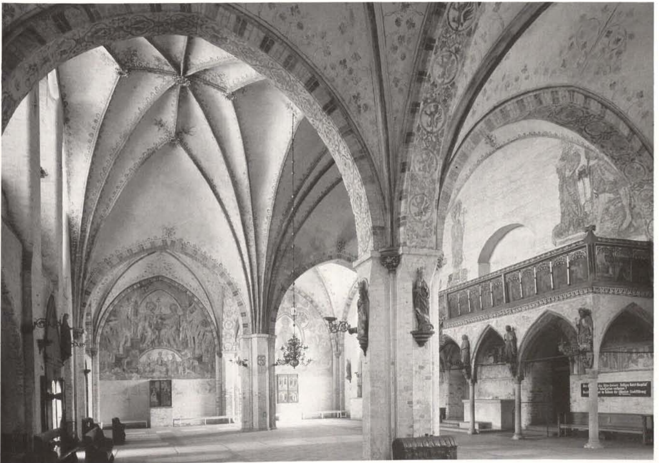
Abb. 69. Lübeck, Kirchenhalle des Heilig-Geist-Hospitals, begonnen um 1265, eingewölbt wohl 1310/15 und 1495, mittelalterliche Ausmalungen seit 1866 wieder freigelegt und ergänzt.
