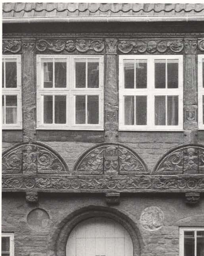
Abb. 74. Lübeck, Hartengrube 20, reich geschnitztes Fachwerk von 1551 (wiederentdeckt 1986).
