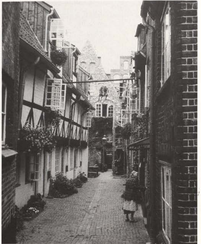
Abb. 71. Lübeck. Hinter dem Haus Engelsgrube 45 hat sich die typische Zeile der Mietsbuden eines 1552 erneuerten «Ganges» erhalten.
