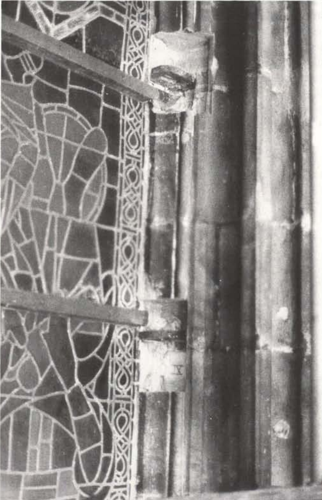
Abb. 9. Dom zu Aachen, Ösen der mittelalterlichen Eisenanker in den Chorhallenpfeilern (1981).
