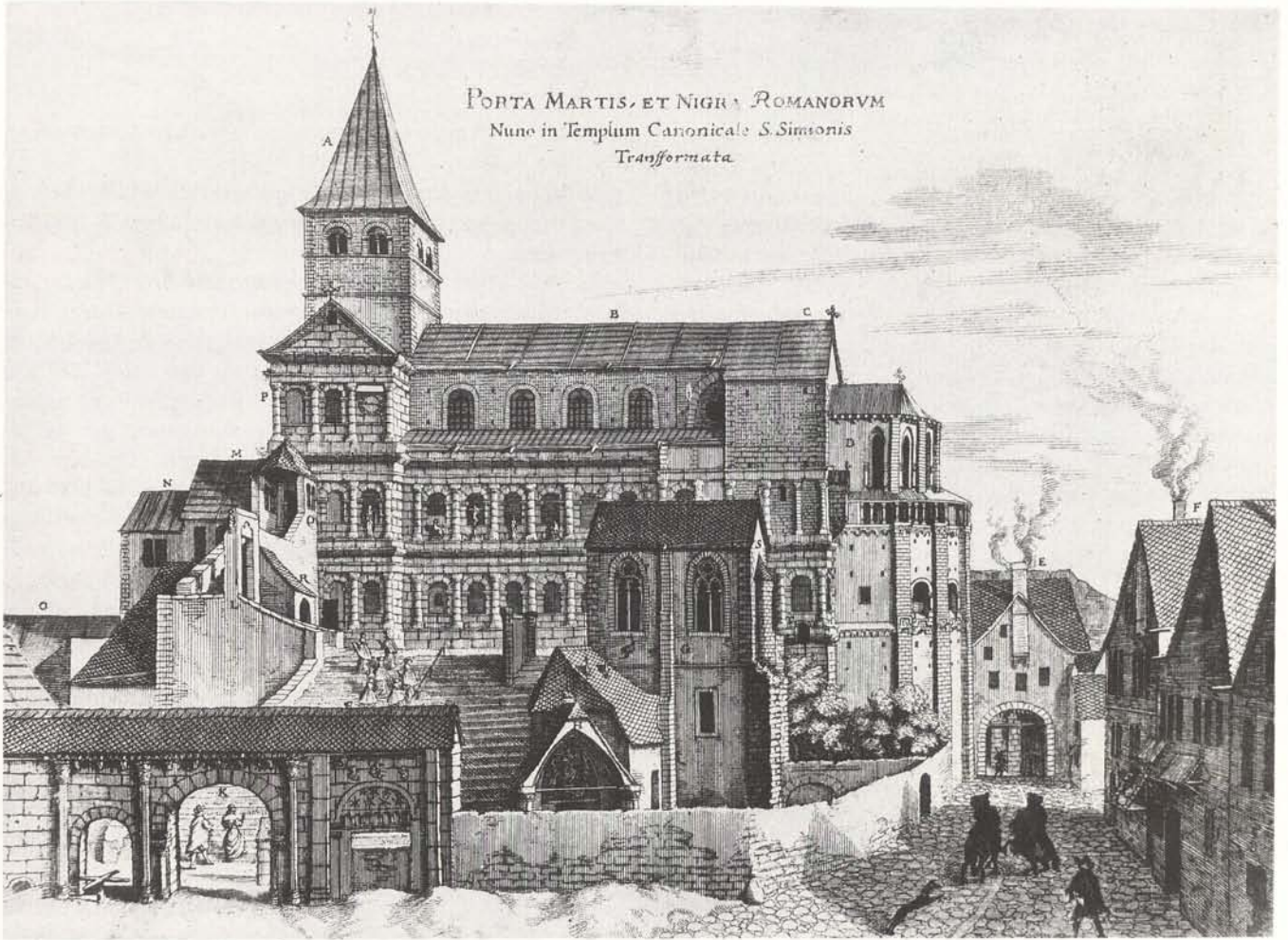
Abb. 49. Trier, Porta Nigra als Simeonstiftskirche, Kupferstich von C. Merian um 1660, Stadtseite: das Erdgeschoß hinter einer Aufschüttung mit Treppenanlage, rechts der um 1140 angebaute Chor.
