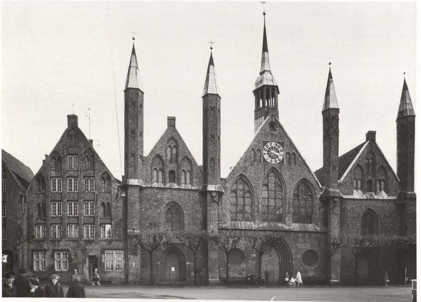
Abb. 66. Lübeck, Westfassade des Heilig-Geist-Hospitals am Koberg, erbaut um 1280.
