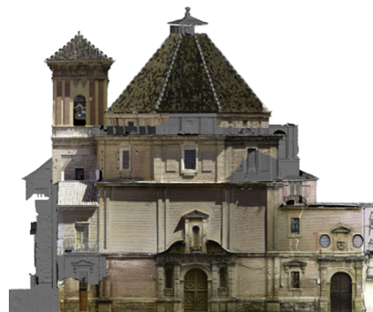
Fig 3. Ortoimagen fachada Iglesia Sto Cristo.
