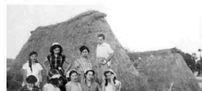
Fig. 2. Chozas de jornaleros en Palma del Río (Córdoba). De horcones (rectangulares-ovaladas), realizadas con maderas arrastradas por los ríos apoyadas en puntales y techadas con muy diversas plantas (caña, carrizo, palmito, enea, junco, paja, etc.) cosidas con torzales de juncia o pita, de aproximadamente 8 x 4 m. Fuente: Pareja Cano, G. y Leiva Blanco, A. (2004): Los pagos de huerta de Palma del Río. En recuerdo de su gente. Palma del Río, Imprenta Lopera, p. 82.
