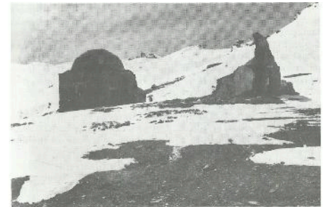
Foto n° 106. Restos del primitivo Albergue de San Francisco, destruido en las postrimerías de la guerra civil (1936-1939). Al fondo el Mojón de Trigo y la aérea silueta del Picacho del Veleta.
