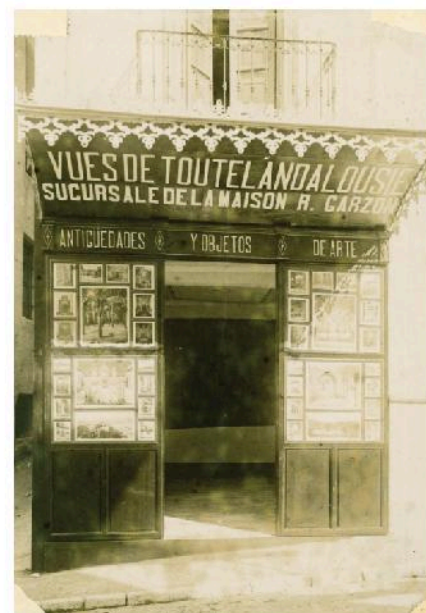
Fig. 1. Marquesina de entrada a la tienda de Rafael Garzón. Calle Almanzora Baja, 1. Fotografía: Rafael Garzón Rodríguez, 1892 © Ayuntamiento de Granada. AMGR (Nº registro: 300804. Signatura: 00.022.12)
