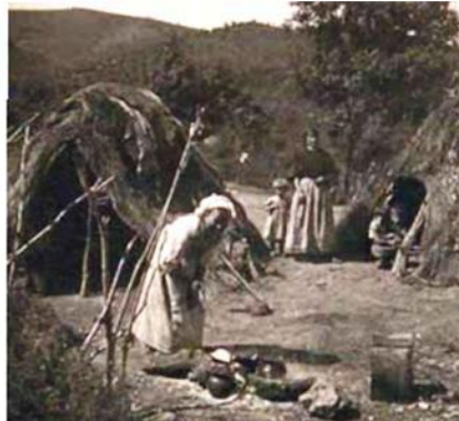
Fig. 8. Chozas de rancheros a finales del siglo XIX. Provincias de Jaén. Circulares y ovaladas desmontables, construidas con varas y paja cosida con torzales, de aproximadamente 2 m. de diámetro. Fuente: Foto de Arturo Cerdá y Rico.
