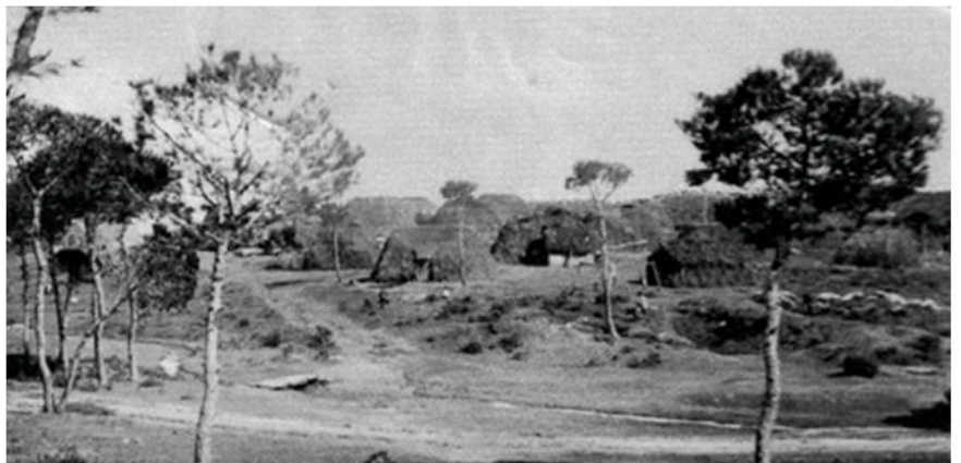
Fig. 10. Chozas de mineros en Cerro Murliano (Córdoba) a principios del siglo XX. Rectangulares y ovaladas, realizadas con maderas y cubiertas de monte-retama-juncos, de aproximadamente 6 x 3 m. Fuente: Colección Pearce. Cortesía del Museo del Cobre.
