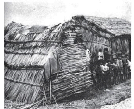
Fig. 9. Chozas de pescadores en Motril (Granada). Rectangulares, a dos aguas (con y sin paredes) realizadas con maderas y techadas con eneas y cañas, de aproximadamente 6 x 4 m. Fuente: Revista Mundo Gráfico, 15 abril de 1936, p. 32.
