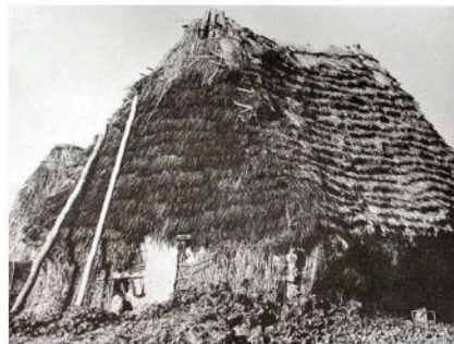
Fig. 5. Chozo en Cabezas de San Juan (Sevilla). Vegetal sobre pies derechos, muy similar a los ranchos marismeños de Doñana, de aproximadamente 6 x 3 m. Fuente: Feduchi L. (1978): Itinerarios...
