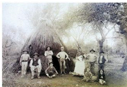
Fig. 1. Chozo de carboneros en Moratalla (Hornachuelos), año 1887. Circular-cónica, realizada con maderas de las mismas talas (en cina, acebuche, etc.) recubierta de monte y paja cosida con torzales, de aproximadamente 3 m. de diámetro. Fuente: Teobaldo de Saavedra y Cueto, primer Marqués de Viana. Fundación Cajasur.
