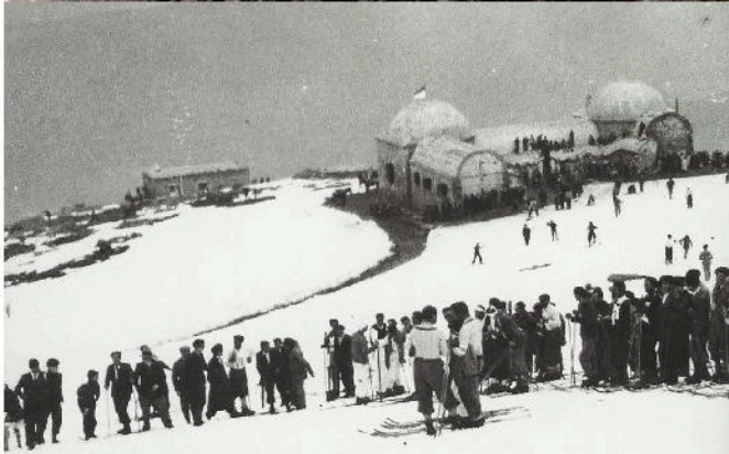
fig 3. El Albergue en fase de construcción. Fondo Carlos Jerez del Valle.
