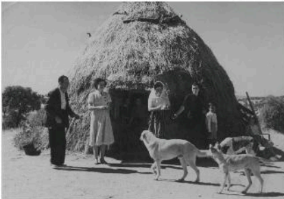
Fig. 3. Chozo de pastores en Cardena (Córdoba). Circular, construido por traba de maderas de encina y forro de monte-retamas y paja riplada, de aproximadamente 4 m. de diámetro. Fuente: Familia Sánchez Pozo.
