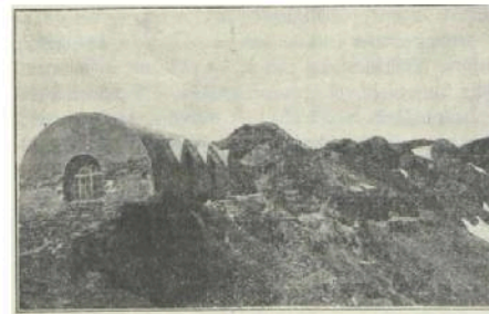
Albergue situado en la cumbre, adecuado para que permanecieran veinte obreros y el personal facultativo y de vigilancia (3.200 m.)
