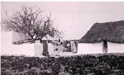
Fig. 4. Chozo de campesinos en Lebrija (Sevilla). Rectangular, mixta de tapial y cubierta de pitones-maderas, techada con diversas plantas o pajas cosida con torzales y cañas, de aproximadamente 5 x 3,5 m. Fuente: Flores, C. (1973): Arquitectura popular...
