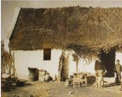
Fig. 7. Chozo de hortelanos en Chipiona (Cádiz). Rectangular con paredes de caña enfoscada y cubierta vegetal, de aproximadamente 10 x 4 m. Fuente: Francisco López Vidal.
