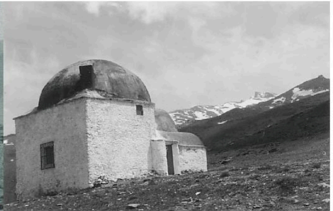
fig 8. Restauración de los restos del edificio, década 1980. Fotografía publicada por Manuel Titos Martínez.
