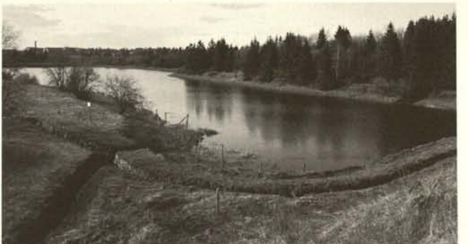
Abb. 9. Clausthal-Zellerfeld. Der im 16. Jh. angelegte Mittlere Pfauenteich zählt zu den ca. 70 heute noch erhaltenen Speicherteichen, die von den Bergleuten zum Betrieb ihrer Wasserräder angelegt wurden.
