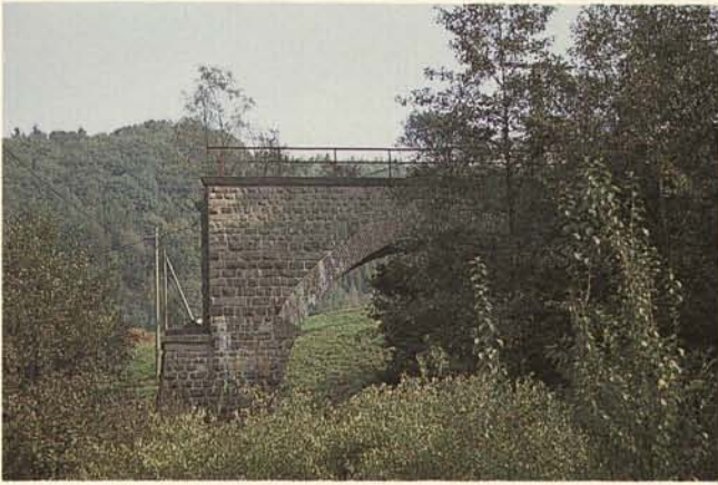
Abb. 3. Ehem. Bahnübergang bei Unterbilstein, Sülzstalstrecke; Erschließung des Raums durch die Bahn im letzten Jahrhundert.
