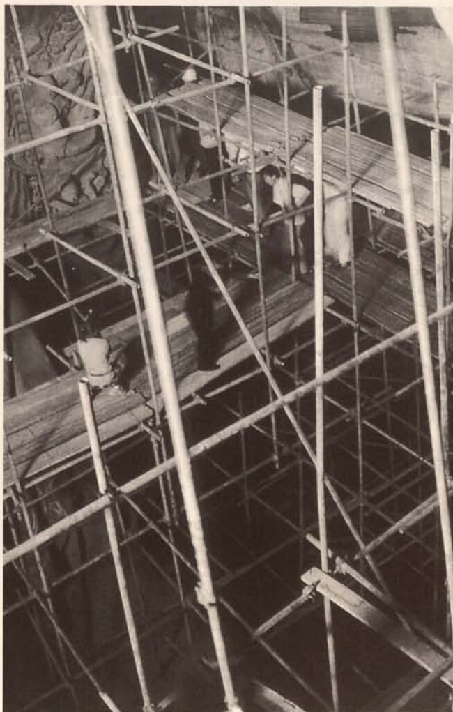
Abb. 1. Gerüstbauarbeiten in Dafosi
