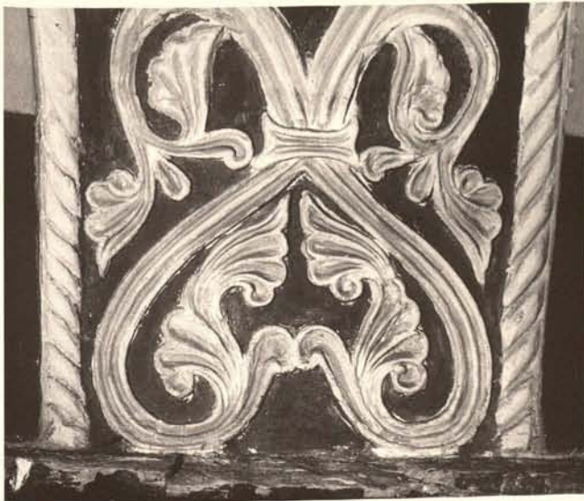
Abb. 132. Hildesheim, St. Michael, südliches Seitenschiff, 4. Arkade, westlicher Ansatz der Bogenlaibung mit zweiphasiger Stuckierung: das Blattmotiv der Phase II ist gegenüber Phase I tiefer modelliert.
