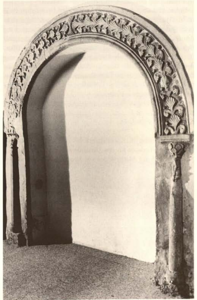
Abb. 125. Oberndorf bei Arnstadt, Kirche, Chor, stuckierte Bogenrahmung einer ehem. Arkadenöffnung zum Seitenschiff.
