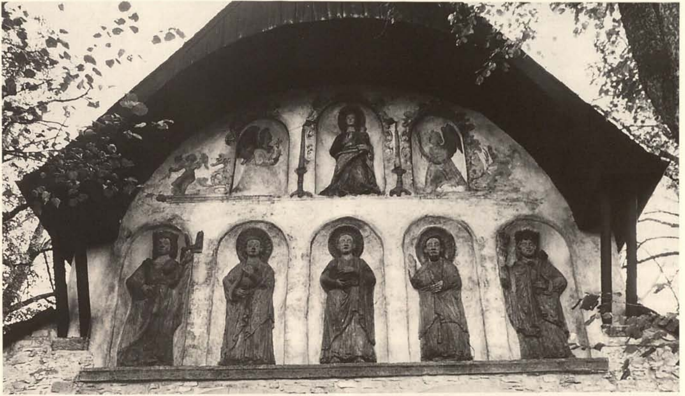
Abb. 191. Goslar, Vorhalle der ehem. Stiftskirche St. Simon und Juda, Giebfeld. Zustand nach Abschluß der Restaurierungsarbeiten (1992).
