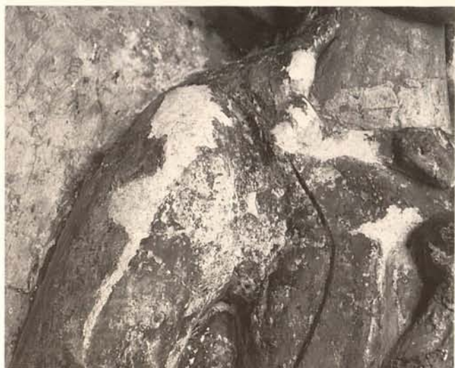
Abb. 194. Goslar, Vorhalle der ehem. Stiftskirche St. Simon und Juda, Giebelfeld, Detail der Marienfigur. Dokumentation des Zwischenzustands nach Reinigung und Kalkmörtelergänzung.
