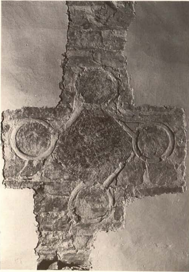
Abb. 71. Corvey, Westwerk. Sog. Johanneschor, Steinscheibendekor an der Nordwand des Quadrums mit weitgehend erhaltenen Putzwülsten um die Scheiben.
