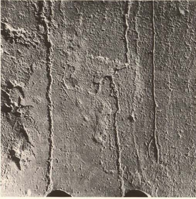
Abb. 184. Moscufo (AQ), S. Maria del Lago, Stuck-Ambo, Detail: Rückseite einer vorgefertigten Platte mit Abdruck eines beim Gußvorgang als Trennschicht verwendeten Gewebes.
