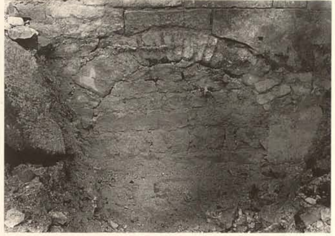
Abb. 77. Hildesheim, Dom, vermauertes Bogenfeld in der Ostwand des südlichen Querhauses (um 1948).
