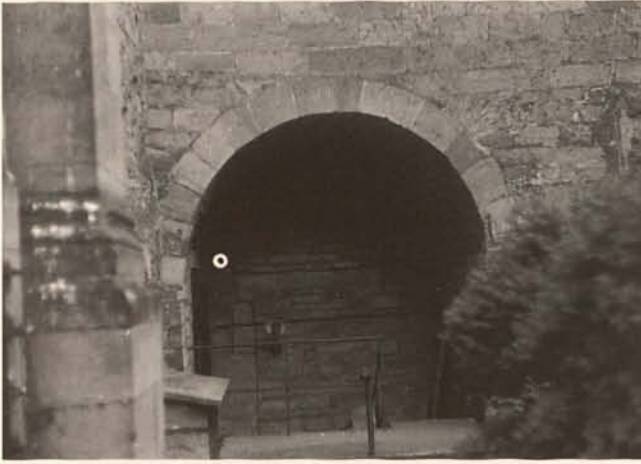
Abb. 74. Hildesheim, Dom, vermauertes Portal in der Ostwand des nördlichen Querhauses (um 1948).
