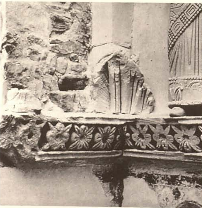
Abb. 34. Cividale, S. Maria in Valle (sog. Tempietto), Westwand, Detail der Südwestecke mit mehrschichtigem Stuckaufbau und Einritzungen auf der untersten Ebene zur besseren Haftung der folgenden Schichten.
