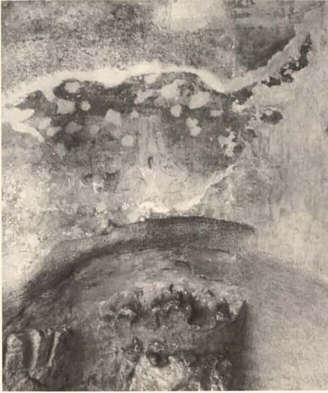
Abb. 188. Goslar, Vorhalle der ehem. Stiftskirche St. Simon und Juda, Dokumentation älterer Fassungsschichten oberhalb der rechten unteren Nische: Reste einer gemalten gotischen Fialenarchitektur als Nischenbekrönung in Fehlstellen der barocken Schlämme.
