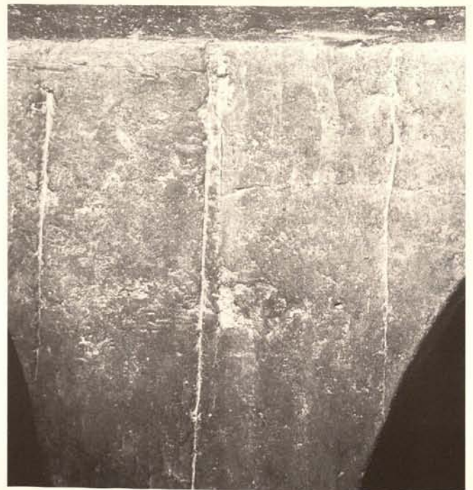
Abb. 137. Hildesheim, St. Michael, Westchor, nördliche Chorschranke, Detail der Nordseite: Ritzungen an Arkadenzwinkel (Streiflichtaufnahme).
