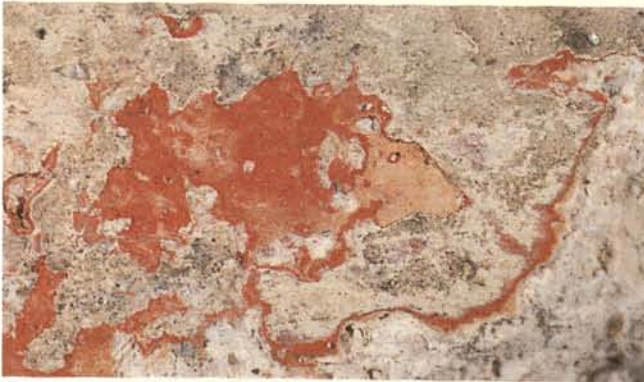
Abb. 147. Stuttgart, Landesdenkmalamt, Stuckfragment aus der ehem. Klosterkirche Großkornburg (Mag.-Nr. 034), Detail mit mehrschichtigem Fassungsauflaufbau: kräftiges Rot als Lasurschicht auf Mennige.
