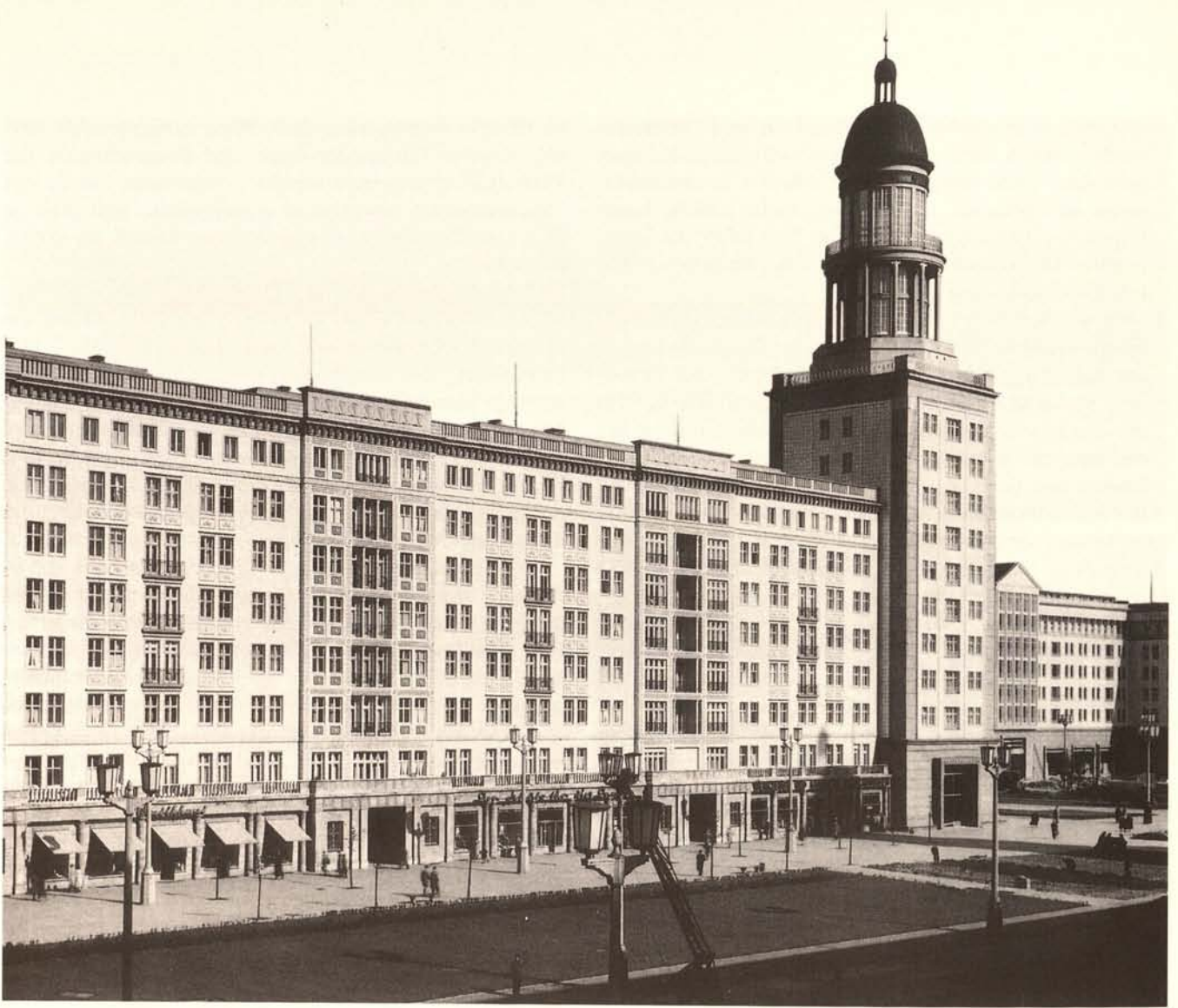
Berlin, Stalinallee (heute Karl-Marx-Allee), Block F-Nord mit einem der Turmbäuser am Frankfurter Tor, gebaut bis 1960
