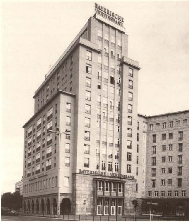
◁ Strausberger Platz, das Haus Berlin und das anschließende Wohnbaus Strausberger Platz 2 nach der Fassadensanierung
