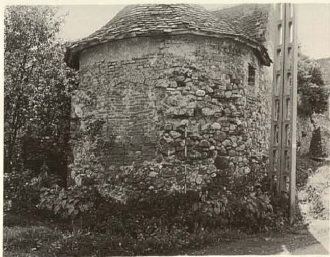
Abb. 168. Detail der türkischen Burgmauer mit dem nordwestlichen Eckturm 168. kép. A török várfal részlete az ÉNy-i saroktoronnyal
