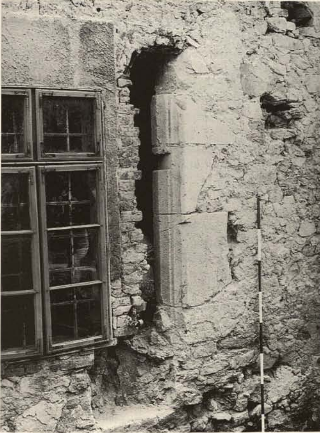
Abb. 136. Der in situ freigelegte Stockstein des gotischen Fensters der Nordfassade 136. kép. Az É-i homlokzat gótikus ablakának „in situ” feltárt szárkőve
