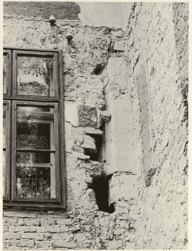
Abb. 138. Stockstein des im Obergeschoß der Ostfassade »in situ« freigelegten gotischen Fensters 138. kép. A K-i homlokzat emeleti szintjén feltárt gótikus ablak „in situ” szárkőve
