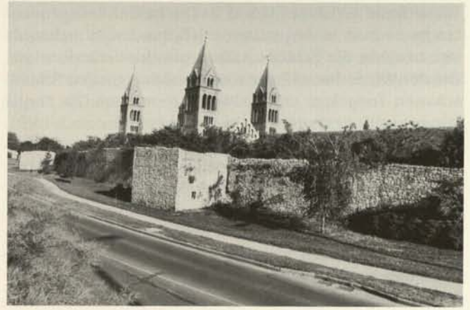
Abb. 53. Die nördliche Burgmauer mit den quadratischen Bastionen nach der Wiederherstellung 53. kép. A helyreállított É-i várfal a négyszögű bástyákkal
