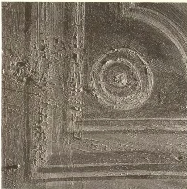
Abb. 3. Markgräfliches Opernhaus Bayreuth, erhebliche Schäden und Verluste von Farbfassung an der Wandverkleidung des Zuschauerraums
