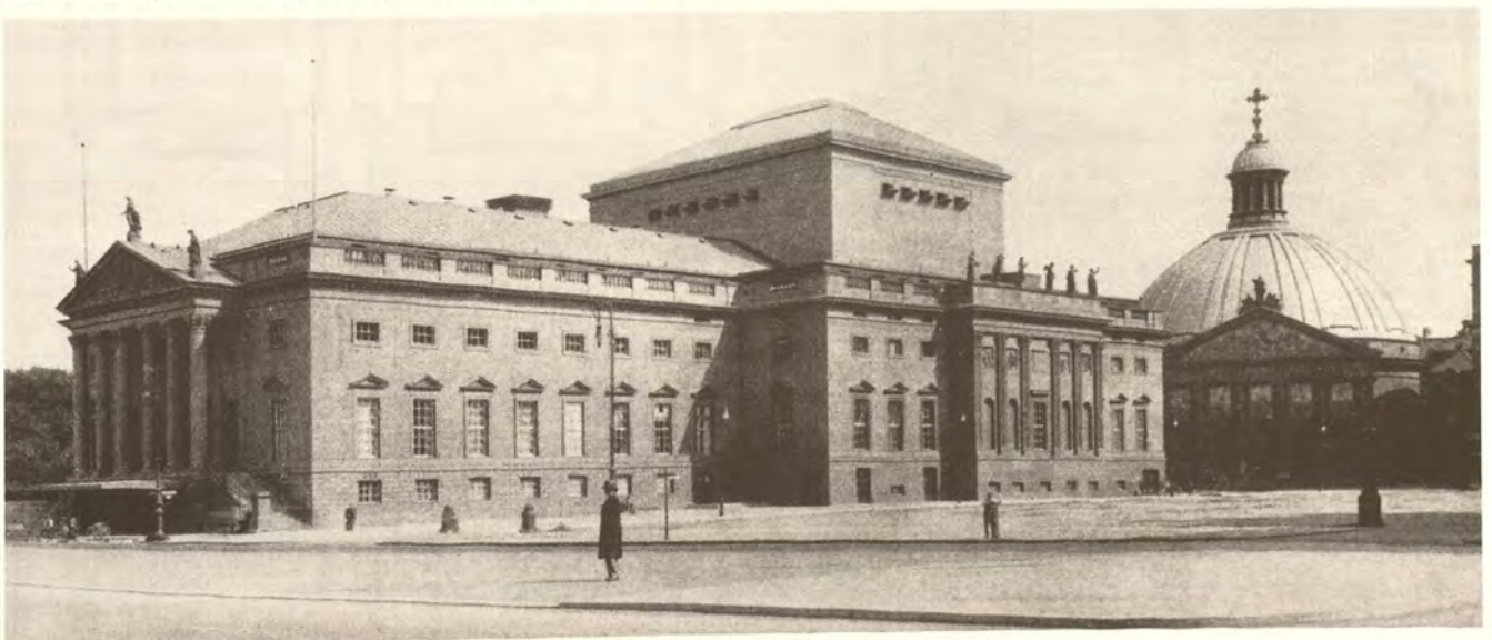
Abb. 9. Berlin, Knobelsdorffsches Opernhaus nach dem Umbau von 1927/28
