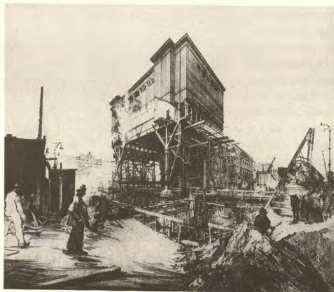
Abb. 7. Paul Hermann, Umbau des Knobelsdorffschen Opernbau- ses 1926/27 mit Abriß des ursprünglichen Bühnenbausteils unter Beibehaltung des Bühnenturms von 1911/12
