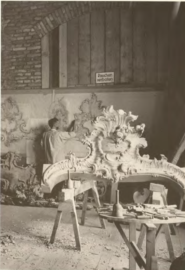
Abb. 19. In den Trierzimmern der Residenz wird an der Rekonstruktion von Logenbegründungen des Dritten Ranges gearbeitet, die (als Stuckersatz für ältere Verluste) nicht geborgen werden konnten. Der Bildhauer entwickelt im Hintergrund neue Formen im Geist der originalen Schnitzerei, die den dokumentierten, kleineren Dekor des 19. Jahrhunderts ersetzen.
