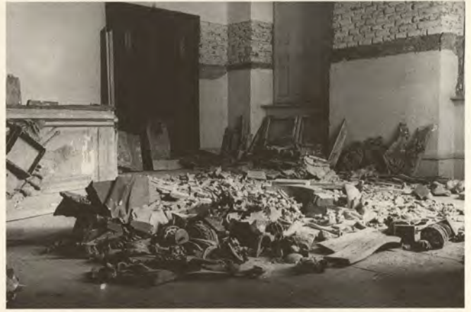
Abb. 6. Fragmente der Logenarchitektur des Residenztheaters im Zustand vor der Neuerleimung. Die Aufnahme entstand im Frühsommer 1956 in Schloß Lustheim bei Schleißheim. Links ist eine der im Kern stabil gebliebenen Brüstungen des zweiten Ranges sichtbar.
