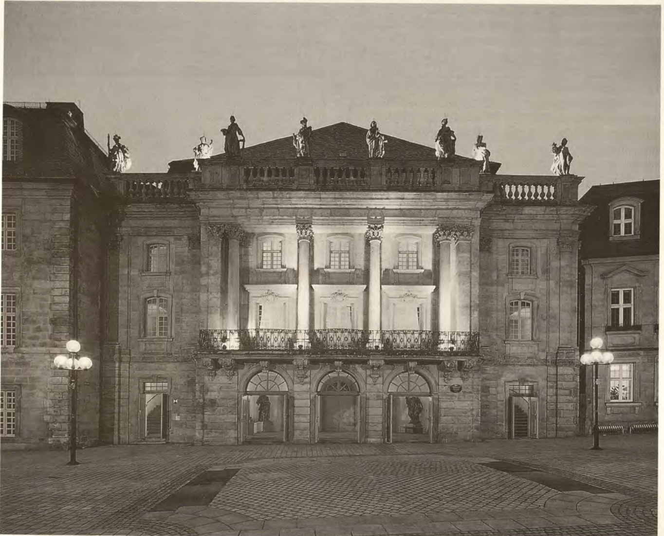
Abb. 2. Die Fassade des Markgräflichen Opernhauses, Architekt Joseph Saint-Pierre
