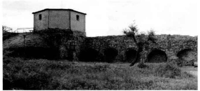
Il torrione visto dall'interno. Si ipotizza che i cinque forniche che si dipartono da esso siano stati gli archi attraverso i quali passava l'acqua del fossato interno del Castelnuovo. Probabilmente, nella condizione primitiva, costituivano la via d'accesso al bastione stesso.
