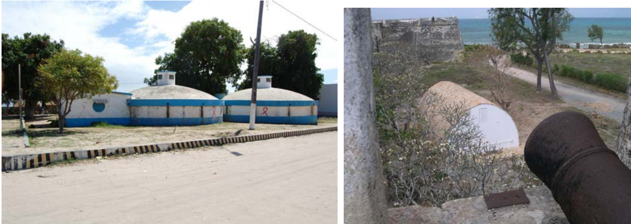
Figura 15.2.: I serbatoi semi-interrati in Ponta da Ilha esistenti dal 1967 al 2013 e il serbatoio a ridosso della cortina della Fortaleza realizzato nel 2009.
