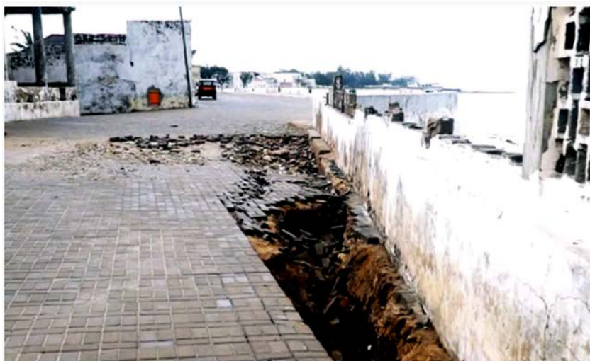
Figura 13.1.: Immagine a corredo dell'articolo dell' O País citato nel testo. Di fronte all'antica sede del Grupo Desportivo de Moçambique , erosione marina della strada marginal lungo la Contra-costa , 2016. [Sullo sfondo la storica Land Rover rossa a passo corto di Jens H.]
