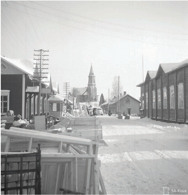
Evakuointi käynnissä 18.3.1940. Etualalla hotelli Kurki ja palokunnantalo, asemakartoissa № 4 ja 12. Sotamuseo
