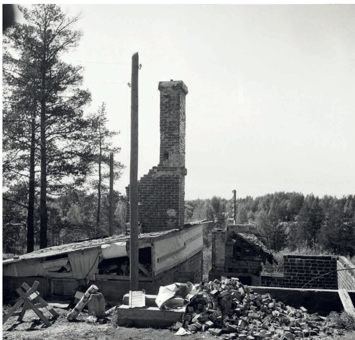
Elisenvaaralaisen talon rauniot 25.8.1943 päivätyssä valokuvassa. Kellarikerroksen sauna muutettiin takaisinvaltauksen jälkeen Elisenvaaran yhteiskoulun johtajan väliaikaisasunnoksi. Pekka Kyytinen. Sotamuseo
