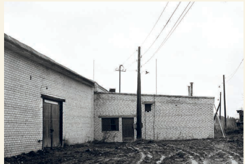
Kurkijoki-sovhoosin kalkkihiekkatiilistä muurattu rehunvalmistusasema Kurkijoen taajamassa. V. P. Soini 1982. NA RK
