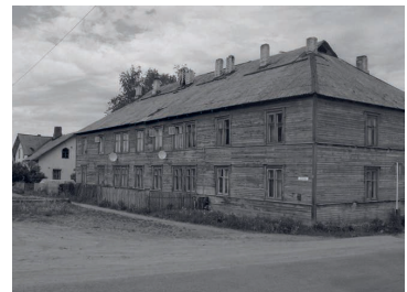
Kaksikerroksinen monen asunnon talo, joka pystytettiin Kurkijoen maamiesopiston palaneen juhlasalirakennuksen paikalle viimeistään vuonna 1953. Asemakartoissa kirjain A. NB 2007
