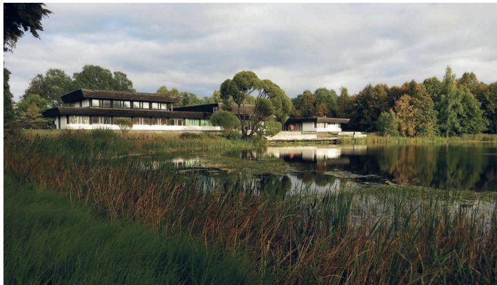
Linda-kolhoosin japanilaisvaikutteinen hallintorakennus Viron Kobelassa. Arkkitehti Toomas Reinin vuonna 1969 suunnittelema kompleksin valmistui vuonna 1973. NB 2022
