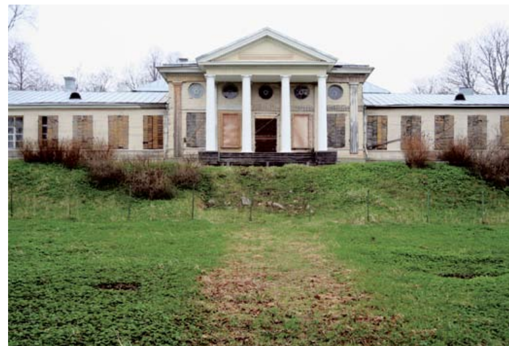
The wooden manor house of Monrepos, built in the 1780s. Photo Roy Mänttari Деревянная усадьба Монрепо, построенная в 1780-х гг. Фото Рой Мянttäри
