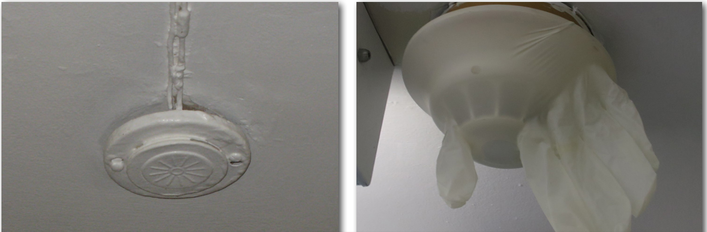
Figura 34. Los sistemas de seguridad contra incendios deben inspeccionarse y probarse regularmente durante este periodo, asegurándose de que no resulten dañados por los trabajos de construcción (por ejemplo, detectores de calor pintados o detectores de humo cubiertos, para limitar las falsas alarmas causadas por el polvo y los escombros).
