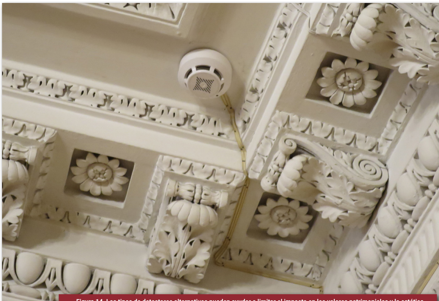
Figura 14. Los tipos de detectores alternativos pueden ayudar a limitar el impacto en los valores patrimoniales y la estética.
