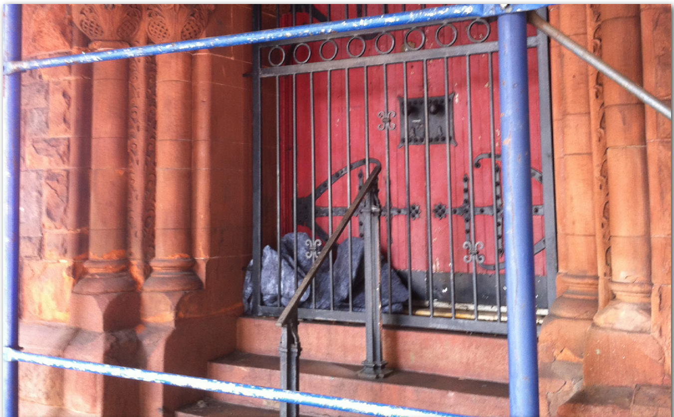
Figura 28. Andamios, puertas, cerraduras, escombros y otros objetos pueden entorpecer las labores de lucha contra incendios.
