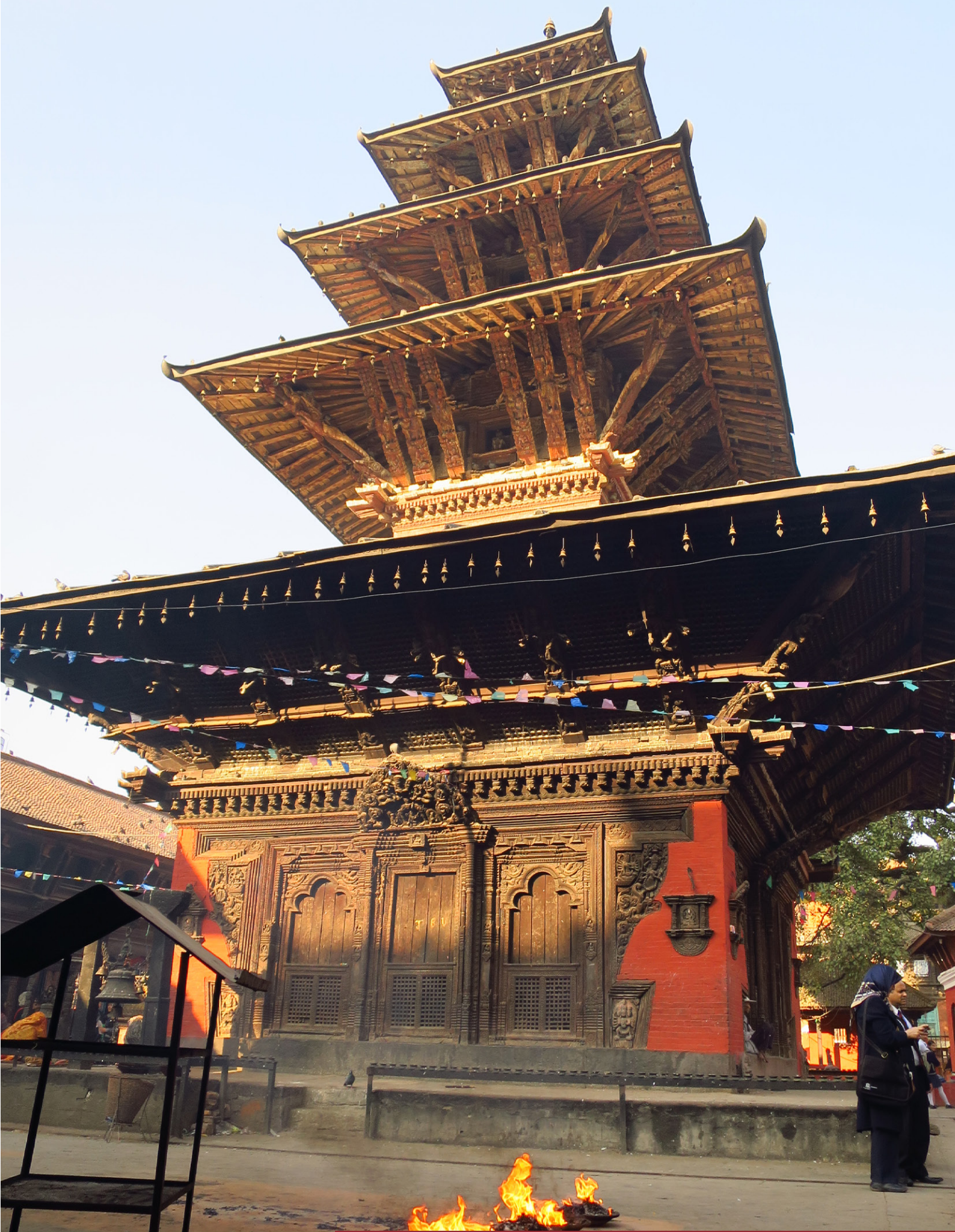
Figura 4. Existen fuentes de ignición tanto dentro como fuera de las estructuras históricas.
