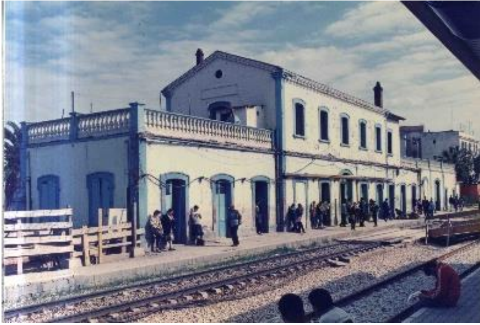
Fig02 : Le bâtiment voyageur Maison-carrée photo avant démolition, archive Sntf.
