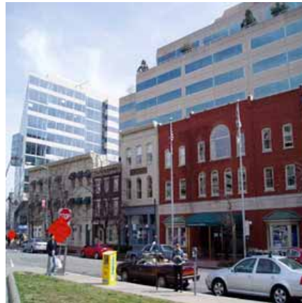
Fig.8 - Façadisme épais pour une rangée d'immeuble 1900 conservée en galerie marchande devant les blocs récents des immeubles de bureaux. Thick façadism of a 19th century low buildings preserved as a shopping arcade.
