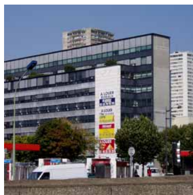
Fig.15 - Bureaux à louer le long du périphérique, un exemple parmi tant d'autres. Un demi million de m2 seraient disponibles à Paris et dans la couronne parisienne. An example among others of offices for renting near the ring road. Half a million m2 would be availables in Paris and suburbs.
