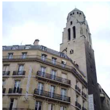
Fig.13 - Dans le 8e arrondissement, près de l'avenue Marceau, les immeubles bourgeois sont progressivement transformés en bureaux. In the 8th district, near Marceau.avenue, burgess apartment buildings are progressively converted in offices.
