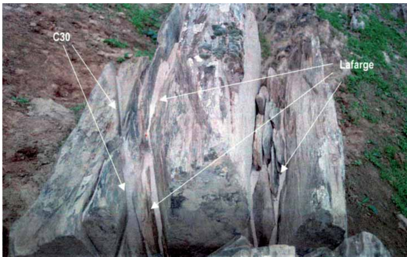
Fig. 12. Rocha-Tipo da Penascosa após ter sido intervencionada pela In Situ com indicação de zonas de aplicação de duas argamassas distintas. (Foto e referência: In Situ, 2005, p. 84).
