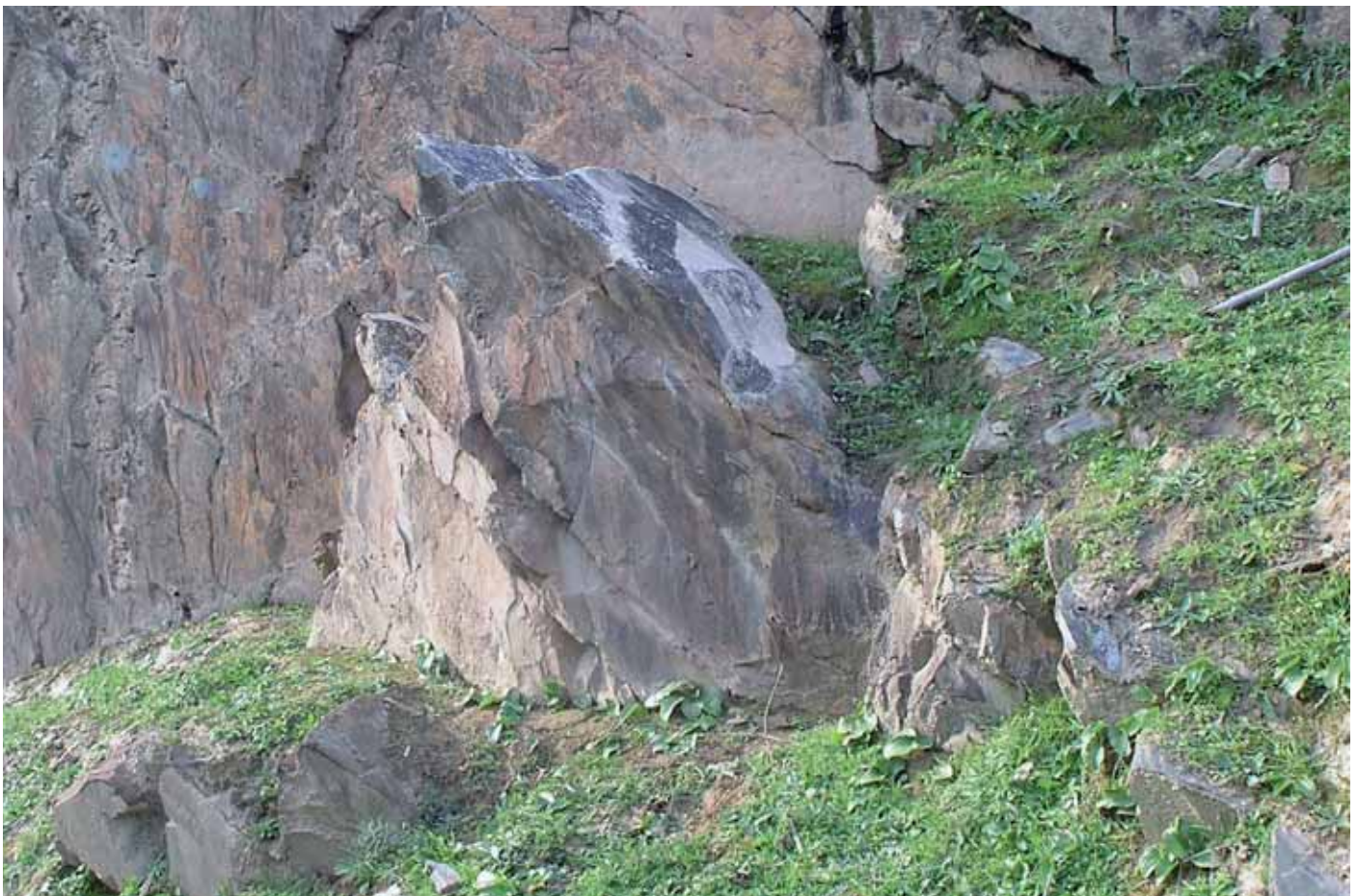
Fig. 13. Rocha-Tipo da Ribeira de Piscos após a intervenção da Nova Conservação. Observam-se fracturas e lacunas da superfície da rocha preenchidas com argamassas distintas bem como o revestimento final de topo que era suposto ser ‘renaturalizado’ com a ajuda das cheias inverniais. (COGHI e PROENÇA, 2005).
